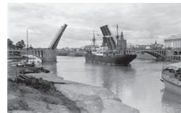
Barco de vela y vapor atravesando el puente de San Telmo [1931-1933] Fotografía: Archivo Serrano Fototeca Municipal. Sevilla
