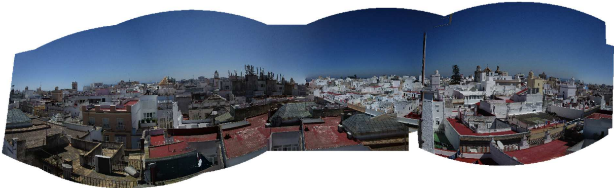
Fig. 49 Panorámica desde el cuerpo superior de la torre, Cánovas del Castillo 17. Fuente: elaboración propia
