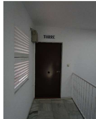
Fig. 36 Puerta de acceso a torre, c/ Cánovas del Castillo 5. Fuente: elaboración propia.
