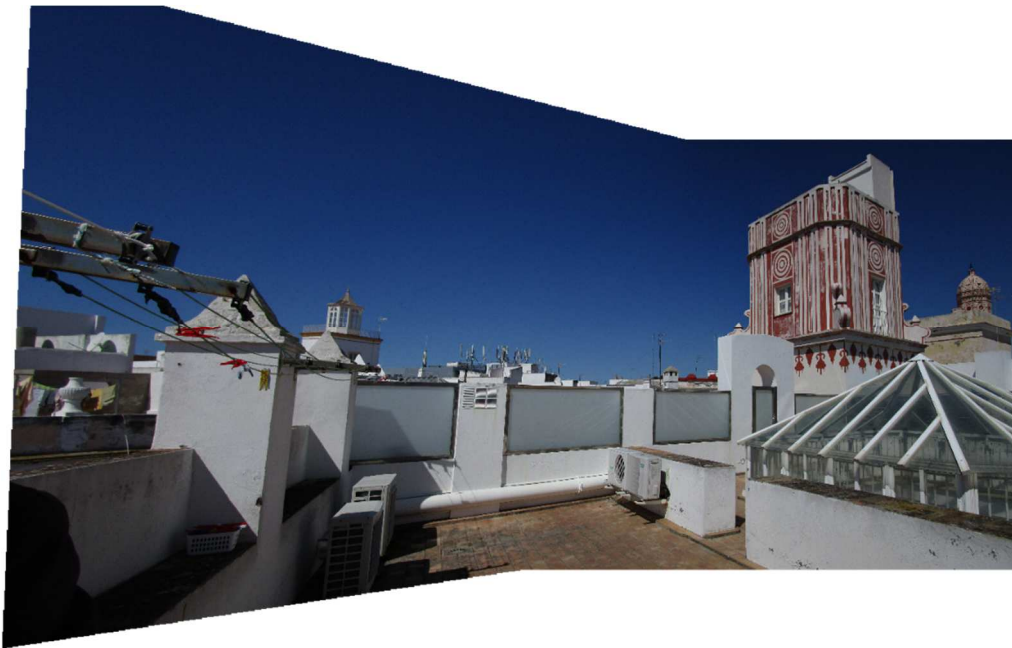
Fig. 46 Panorámica desde azotea, c/Valverde 10. Fuente: elaboración propia.
