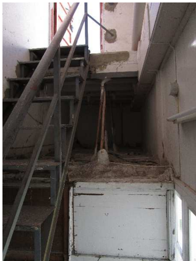
Fig. 39 Escalera de acceso a azotea, c/ Cánovas del Castillo 37. Fuente: elaboración propia.
