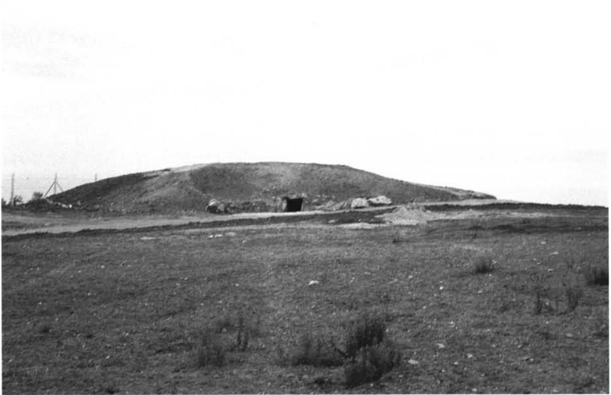
Fig. 13: Vista general una vez concluidas las obras.
