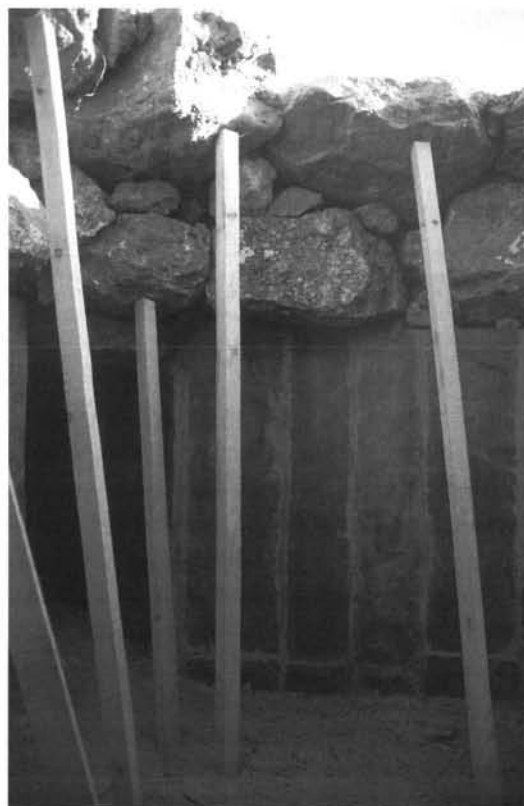
Fig. 8: Cámara principal una vez forrada y apuntalada la segunda hilada de la bóveda.
