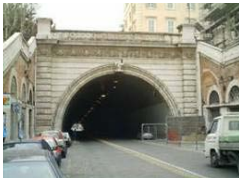
Fig. 11: Entrada desde la avenida Nazionale
