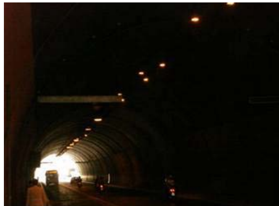
Fig. 12. Foto tomada antes de la reforma
