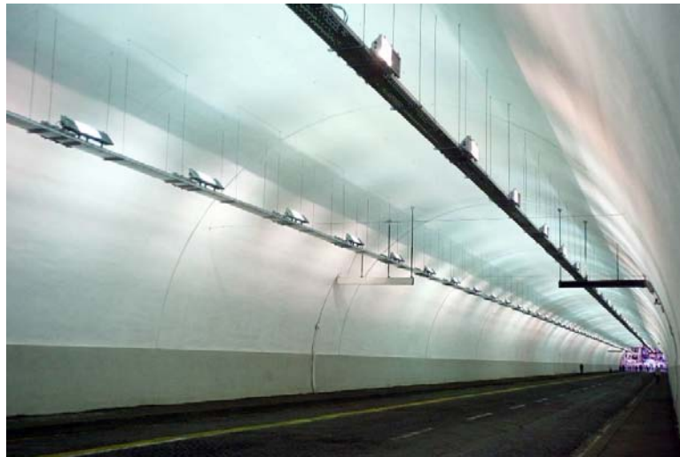
Fig 13. Foto tomada después de la reforma.
