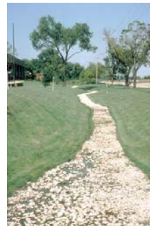
Fig.4. Zanja en Lago Oswego (Oregón, EEUU). (Pitt, 2005)
