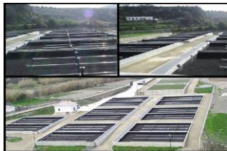
Fig.5. Filtros de turba en EDAR de Ugíjar (Granada).
