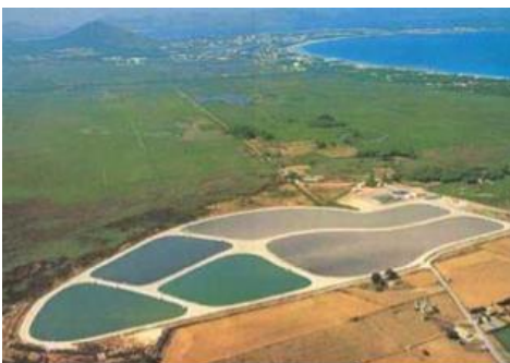
Fig.6. Lagunaje Muro-Santa Margarita (Mallorca). (CEDEX, 2010)
