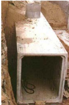
Fig.2. Cajón de servicios ( http://editorial.dca.ulpgc.es , 2014) Fig.3. Galería visitable ( http://editorial.dca.ulpgc.es , 2014)
