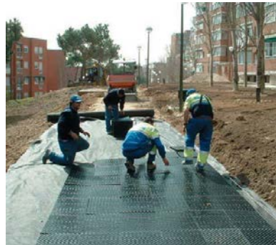
Fig.7 y 8. Parque de Gomeznarro (Madrid). Pavimento acabado y colocación. (drenajurbanosostenible.org, 2015)
