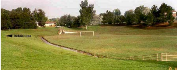
Fig.6. Depósito de detención en área deportiva con canal de bajo flujo. Fuente: udfcd.org.
