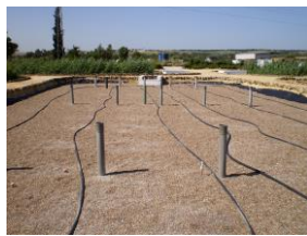
Fig.9. Humedal vertical (sin vegetación) en Carrión de los Céspedes (Sevilla). (Grupo TAR, 2010)
