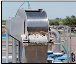
Fig.7. Tamices rotativos (CEDEX, 2010)
