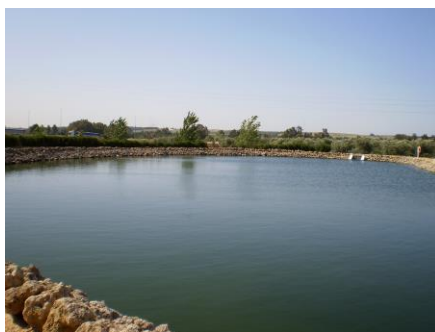
Fig.4. Laguna Facultativa. Carrión de los Céspedes (Sevilla). (Grupo TAR, 2010)
