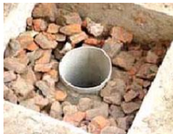
Fig.2. Pozo de infiltración con relleno granular
