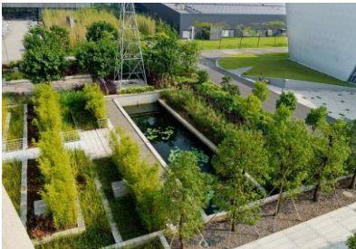
Fig.6. Estanque de retención en Campus de la Universidad de Shenzhen (China). (Hai Zang)
