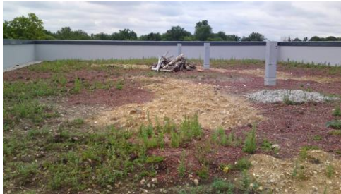
Fig.12. Cubierta biodiversa (drenajearbanosostenible.org, 2015)
