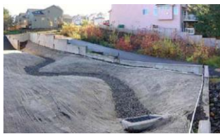
Fig.4. Dren filtrante sin tubo (ecoprojecta.es, 2015)
