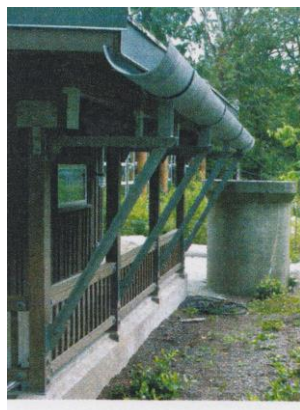
Fig.3. Depósito en superficie (Kwok y Grondzik, 2011)
