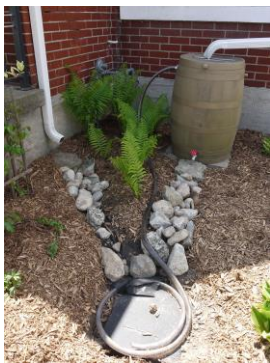
Fig.6. Pozo de infiltración en patio de vivienda (Reep Green Solutions)
