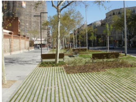
Fig.2. Pavimento permeable. (sdus.webnode.es, 2015)
