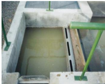
Fig.2. Desengrasador estático. (CEDEX, 2010)
