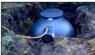
Fig.4. Instalación fosa séptica prefabricada (Grupo TAR, 2013).
