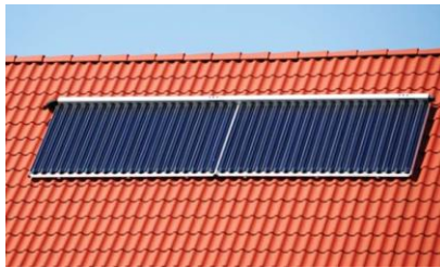
Fig.4. Captador de tubo de vacío (AAE, 2009)
