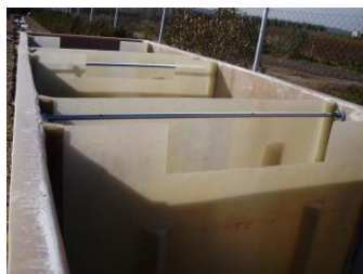
Fig.2. Detalle tajaderas flujo FAV (Pozo-Morales, 2010)
