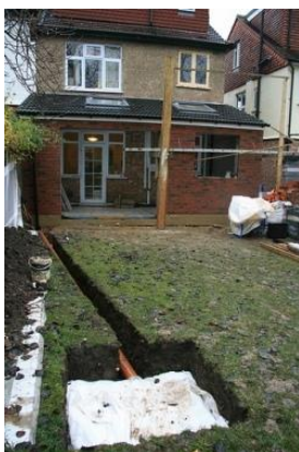
Fig.7. Instalación de un pozo de infiltración (Canadá). (The Sustainable Technologies Evaluation Program)
