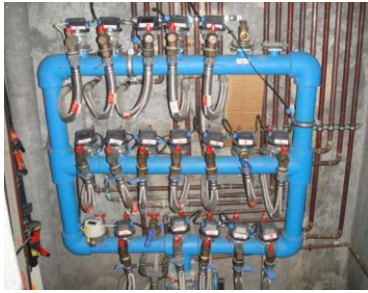
Fig.2. Batería de contadores (www.generadordeprecios.info) Fig.3. Contador individual (www.valgroup.es, 2015)
