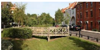
Fig.10. Cuneta verde en la comunidad de Upton (Northamptonshire, UK)
