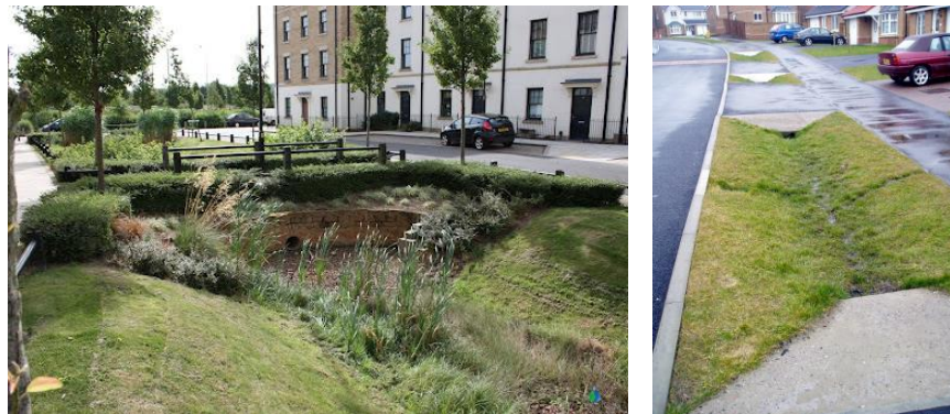
Fig.2 y 3. Cunetas verdes
