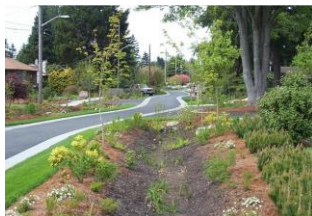
Fig.6. Cuneta verde seca no tapizada con diferentes especies vegetales. (Seattle Public Utilities, 2015)
