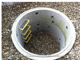
Fig.5. Pozo de infiltración con cámara.
