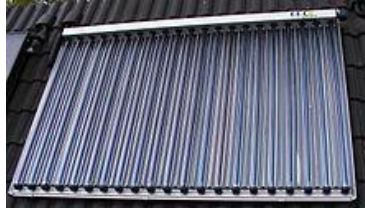
Fig.6. Captador solar de tubos de vacío sin tubo de cobre
