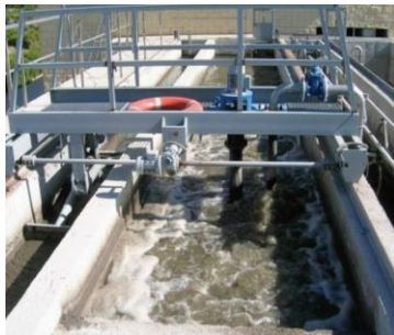
Fig.4. Desengrasador-desarenador con puente móvil. (CEDEX, 2010)
