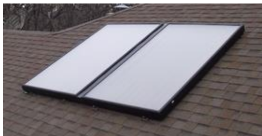
Fig.3. Captador solar plano (AAE, 2009)
