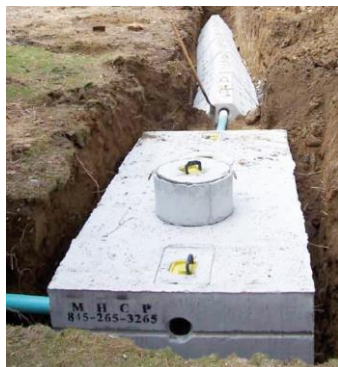
Fig.5. Fosa séptica prefabricada en hormigón. (CEDEX, 2010)
