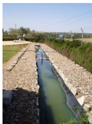
Fig.3. Reactor Baccou en Planta Experimental de Carrión de los Céspedes. (Grupo TAR)
