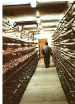
Fig.2. Cajón de servicios ( http://editorial.dca.ulpgc.es , 2014) Fig.3. Galería visitable ( http://editorial.dca.ulpgc.es , 2014)
