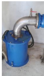
Fig.4. Pozo de infiltración. Pisa (Italia). (Proyecto Dina-Mar, 2011)
