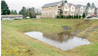
Fig.2. Depósito de infiltración superficial. (stormwaterpartners.com)
