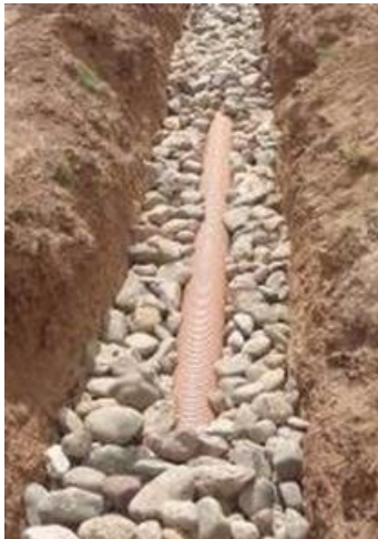
Fig.2. Zanja con relleno granular ( www.fcpa.org.pe/mostrarPublicacion.php?id=69 , 2015)
