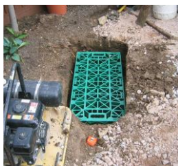
Fig.3. Pozo de infiltración con módulo geocelular.
