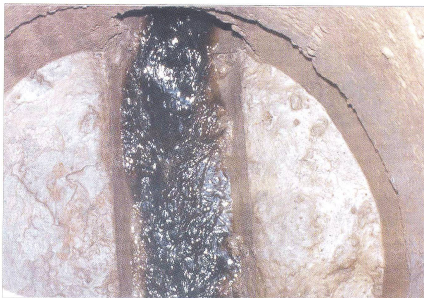
Fig. 2.- Estado del agua tras la primera limpieza realizada en la calle San José. Puede apreciarse la gran cantidad de sólidos en suspensión.
