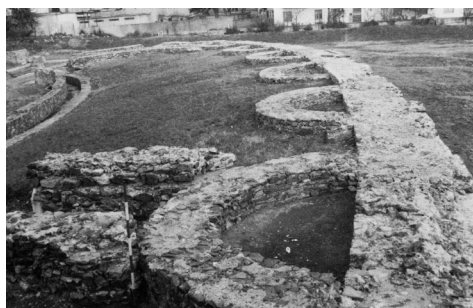
Fig. 6.- Detalle de los contrafuertes absidados de vittatum del anfiteatro de Eporedia (foto de A. Giardini, tomada de: Magi 1987: tav. XXX, fig. 56).
