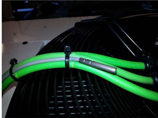
Figura 2.22. Imagen de la sonda de temperatura Pt100 situada en la salida de aire del ventilador
