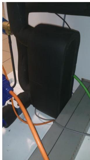
Figura 2.8. Evaporador aislado del recinto de -20°C
