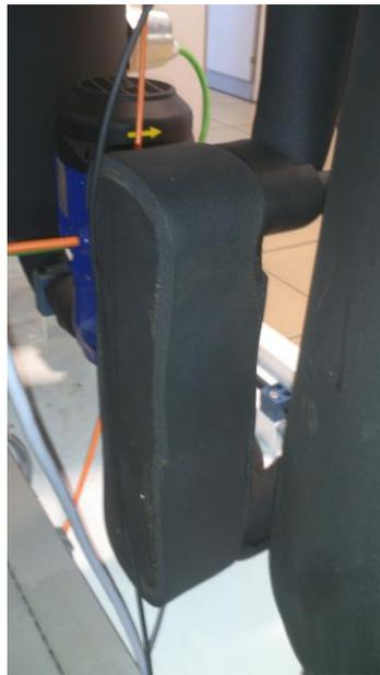
Figura 2.7. Evaporador aislado del recinto de 5°C
