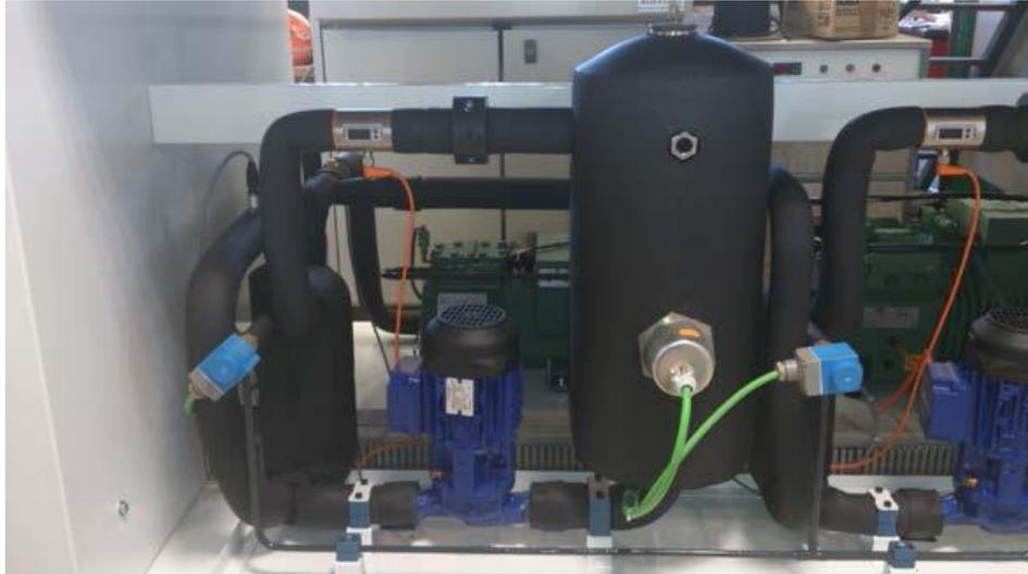
Figura 2.14. Circuito de glicol para el recinto a  $-20^{\circ}\text{C}$
