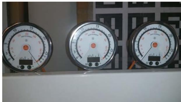
Figura 2.18. Imagen de los manómetros instalados en la planta
