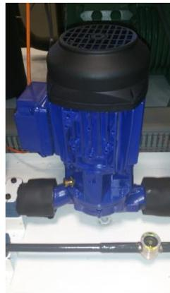
Figura 2.11. Imagen de una de las bombas de impulsión de la solución de glicol
