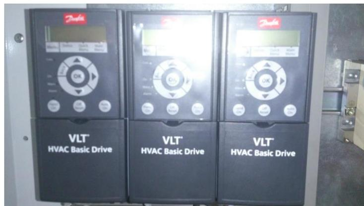
Figura 2.16. Variadores de frecuencia de las bombas de impulsión de líquido
