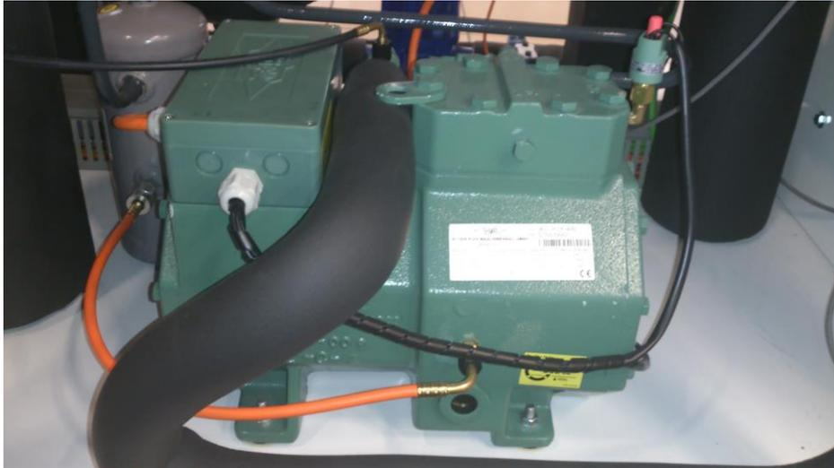
Figura 2.5. Imagen del compresor *booster*
