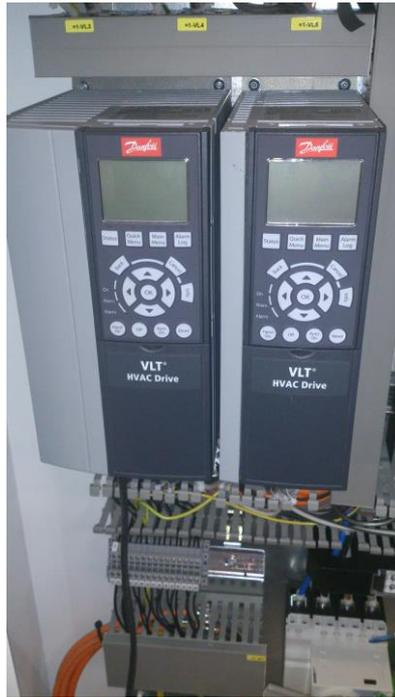
Figura 2.15. Variadores de frecuencia de los compresores
