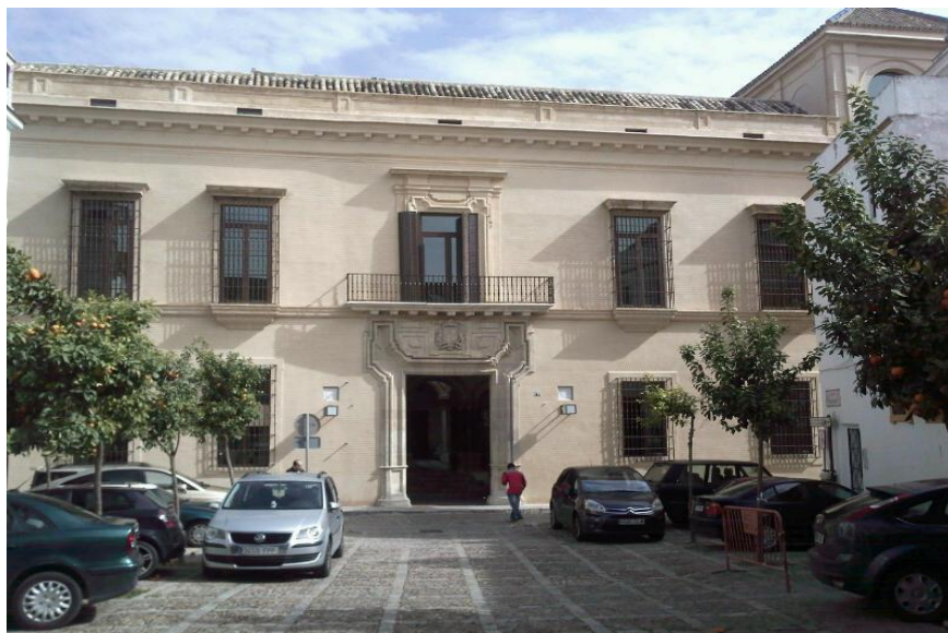
Fig. 5.6 Fachada desde la plazuela. Foto propia.
