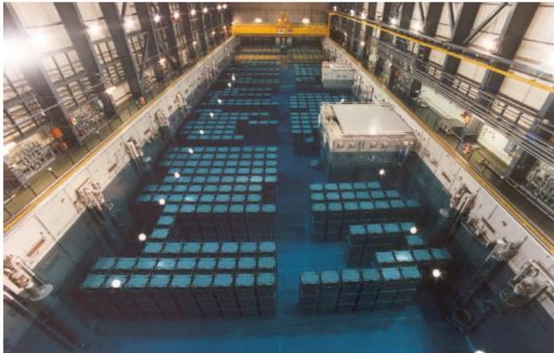
Figura 4.5. Almacenamiento de combustible ya utilizado en las piscinas del reactor.
