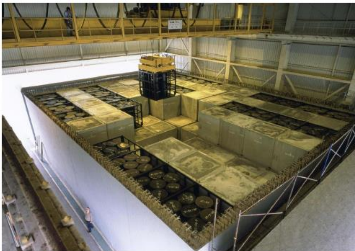
Figura 5.6. Celda de almacenamiento de la instalación ubicada en el Cabril.
