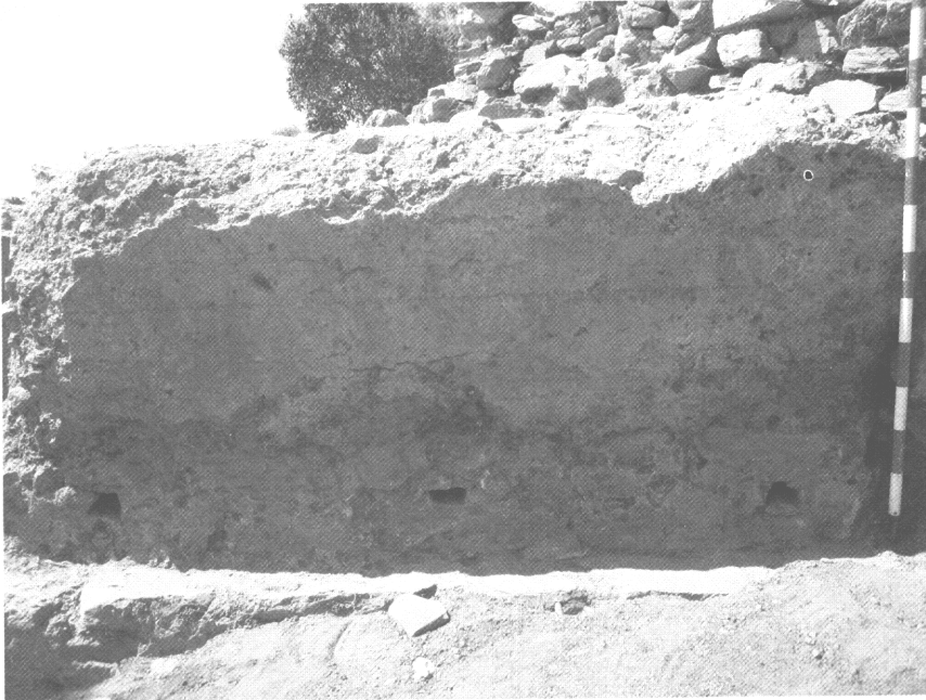
6.- Mechinales constructivos, taponados y sin taponar. Fig. 122 de la Memoria.
