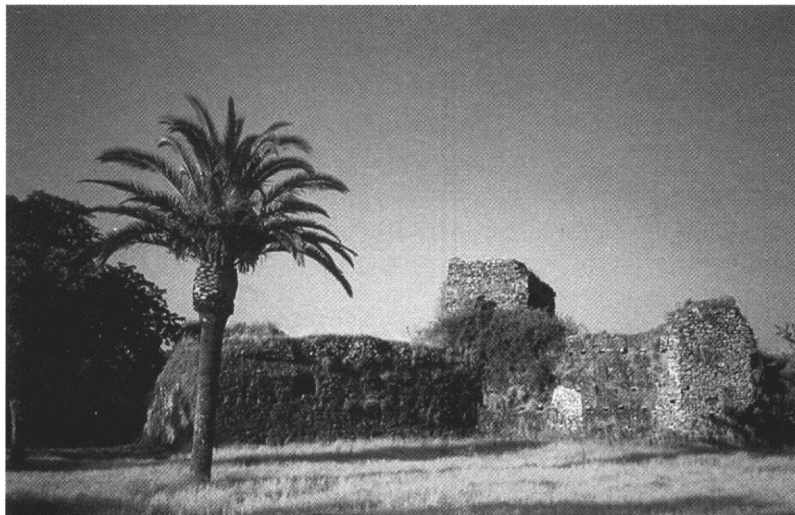
13.- Muro diafragma y cámara alta del aljibe.
