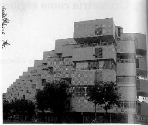
Figura 2 Edificio de Viviendas en la Avda. República Argentina, Córdoba (Pabellones Militares). Foto del autor
