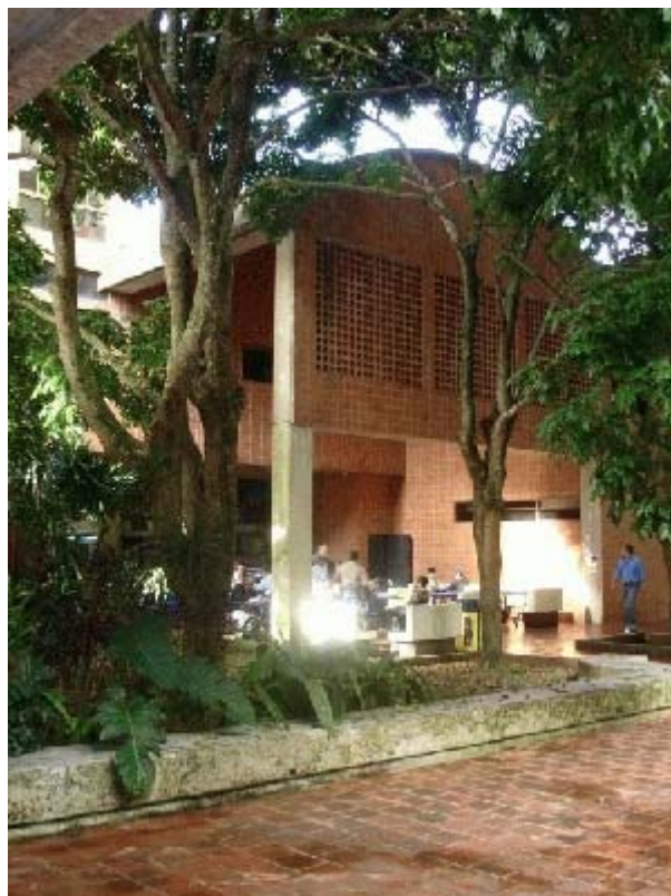
Figura 3-91: Edificio de Postgrado.
