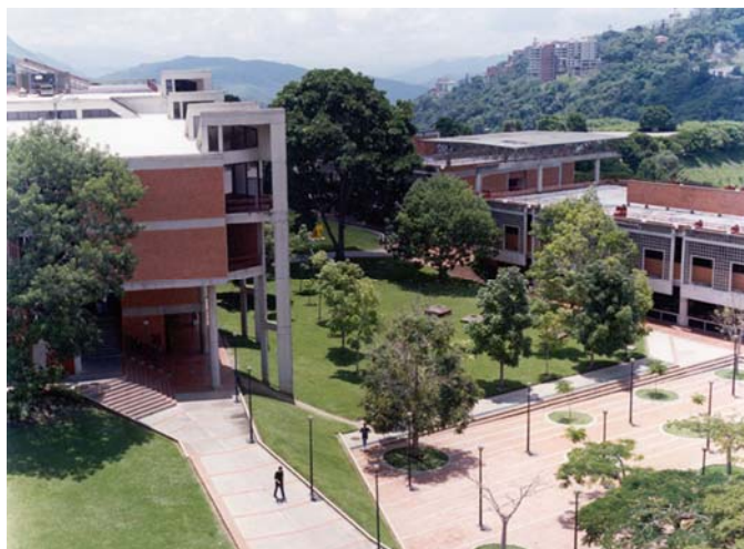
Figura 3-73: Vista del Módulo de Aulas y el Edificio Corimón
