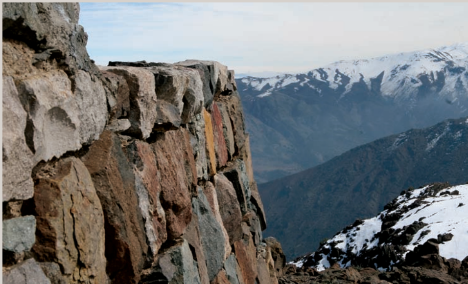
09 Rugosidad e individualización de bloques de piedra en un paño de mampostería en la obra de Germán Rodríguez Arias en Farellones, Chile
