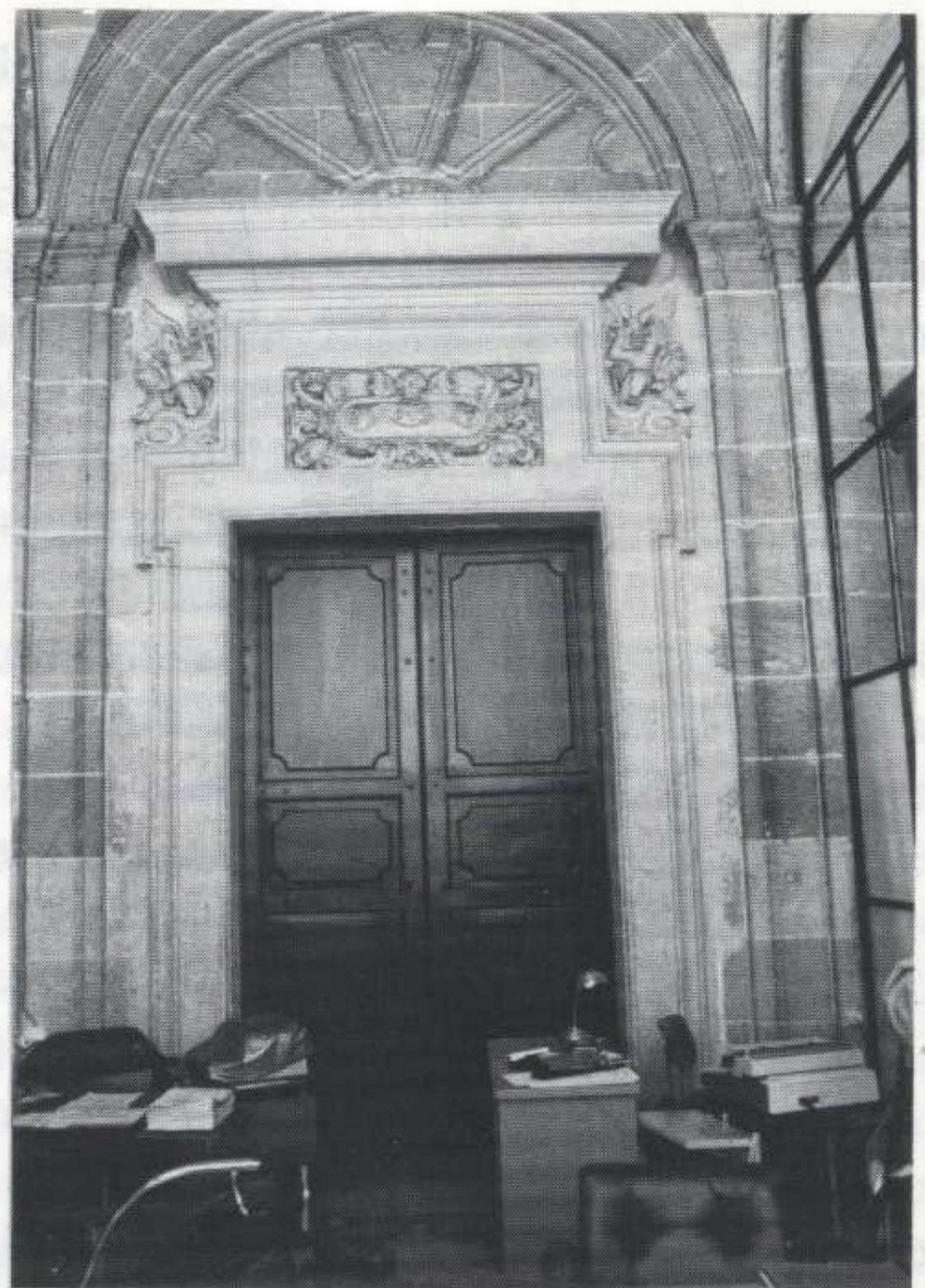
Fig. 8. Casa Lonja de Sevilla, galería del ala norte del patio, portada
