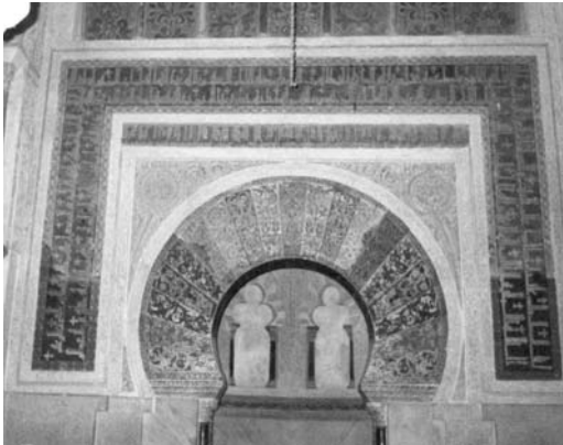
Figura 2 Mosaicos del mihrab con las restauraciones visibles
