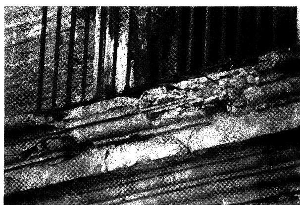
f) Orientación Suroeste. Nivel 2. Efecto de los hierros.
