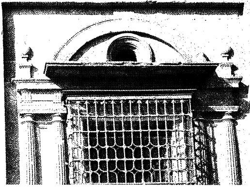
a) Pequeñas fragmentaciones en todas las molduras y ángulos.
