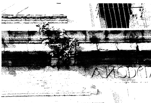
d) Orientación Suroeste. Nivel 3. Arenizaciones y fragmentaciones.
