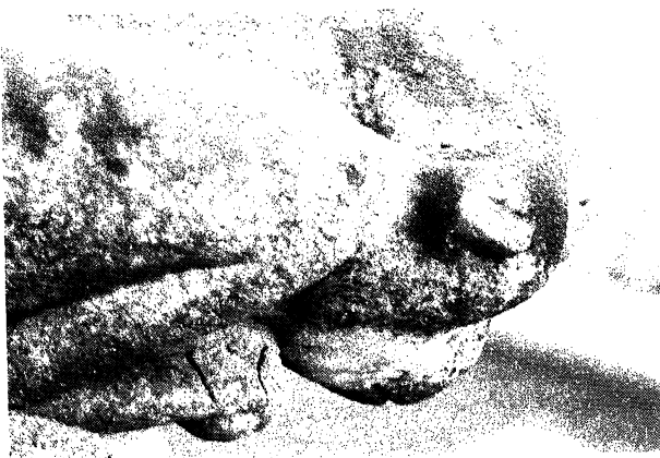
e) Fisuras y fragmentaciones en las gárgolas.
