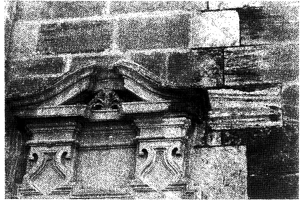
b) Contraste entre zonas con pátina y depósitos y zonas lavadas.
