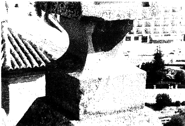
e) Fisuraciones en reconstrucciones hechas con morteros de la piedra.
