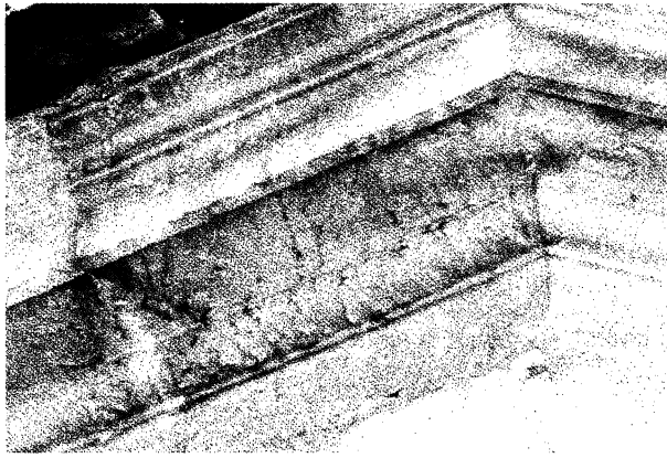
a) Disyunciones de películas debajo de las cornisas.
