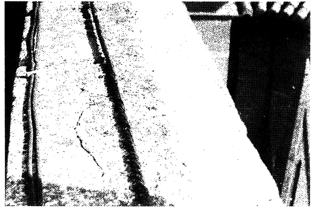
b) Grandes fisuras en los antepechos.
