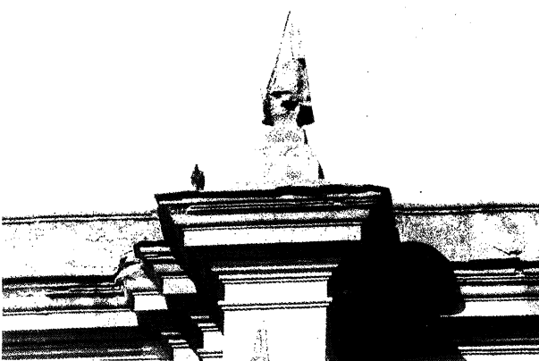
e) Disyunción de placas en antepecho. Arenización en cornisas y pináculos.
