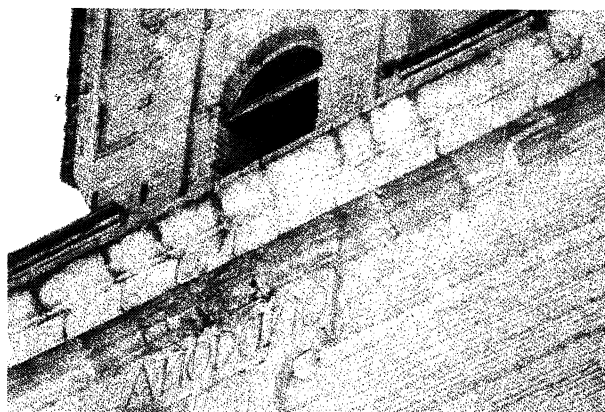
b) Orientación Noroeste. Nivel 3. Disgregaciones y agentes biológicos.
