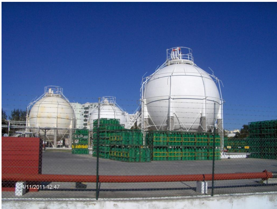
Figura 114 – Armazenamento químico de combustíveis: Depósitos de gás da BP em Faro.
