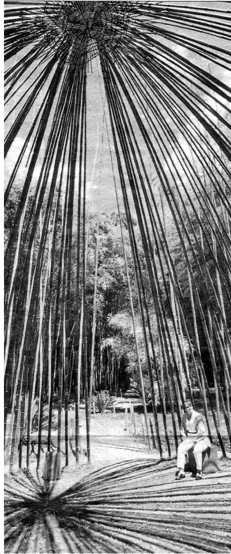
Fig. 1. Construcción de bambú en la Bambouseraie de Anduze (Francia).
