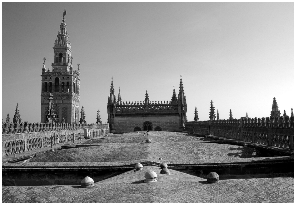
Fig. 22. Cubierta sobre las bóvedas altas en la Catedral de Sevilla.
