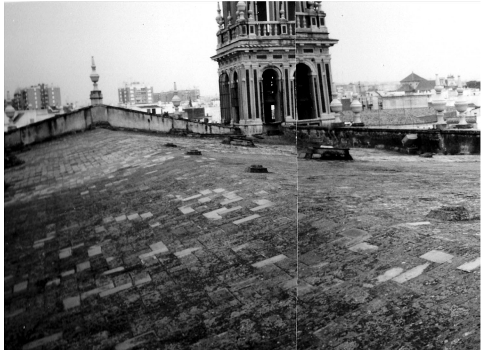
Fig. 11. Azotea de la iglesia de Santa Ana (Sevilla).
