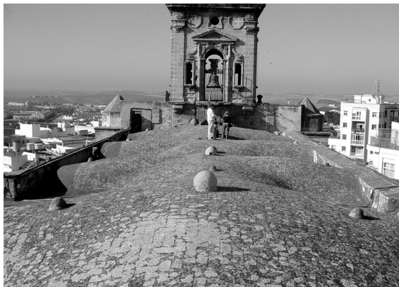
Fig. 17. Cubierta sobre bóvedas altas.
