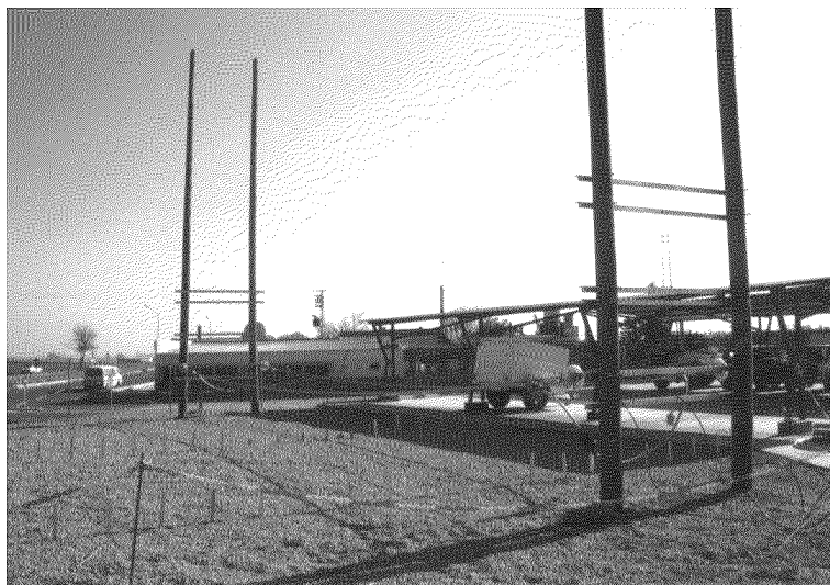
Figura 7.14: Estructura soporte para el vano de prueba
