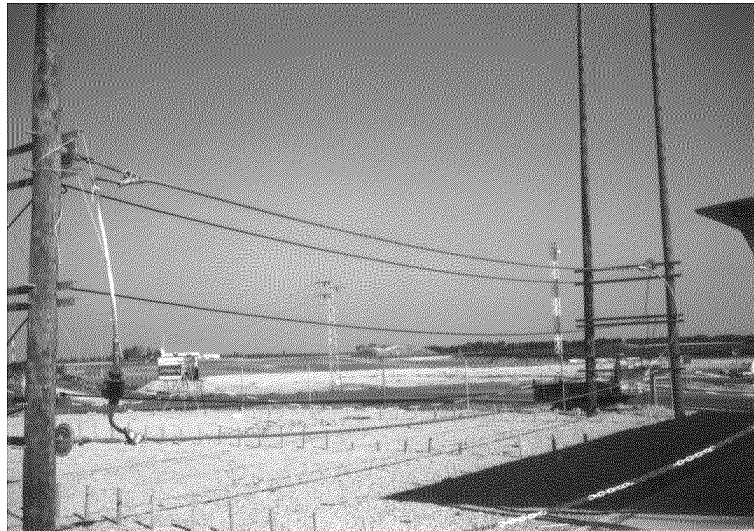
Figura 7.39: Conductores de fase en disposición vertical y lazo de mitigación
