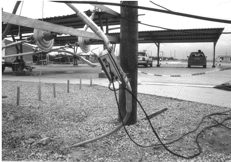
Figura 7.47: Extremo del lazo v3 conectado al transformador de intensidad
