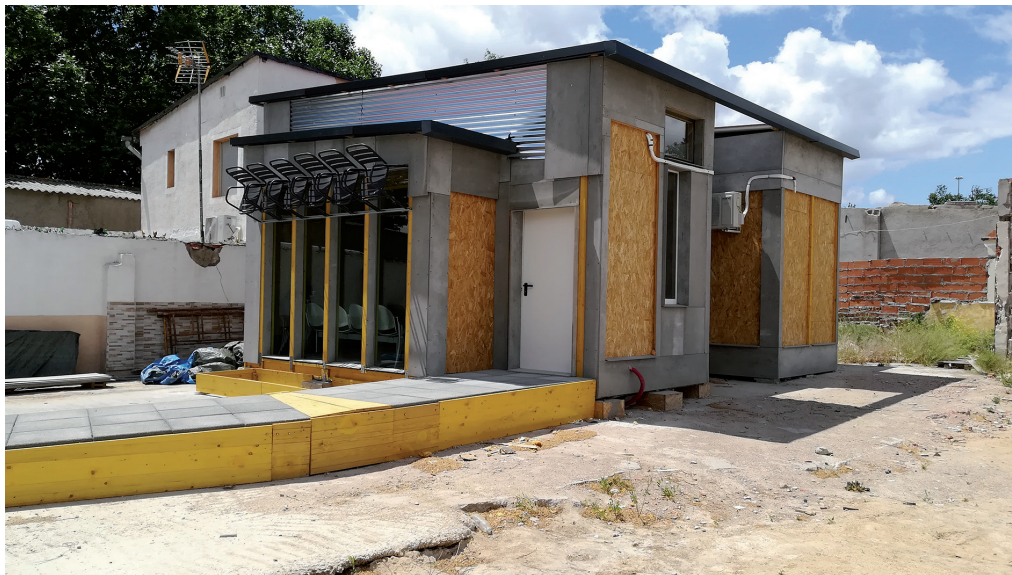
Fig. 6. Fotografía del exterior de la sala de usos múltiples, donde se aprecia la reutilización de sillas como parasol. Recetas Urbanas.
