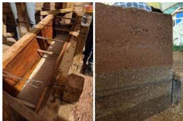
Figura 3. Encofrado y muro de tapia.
