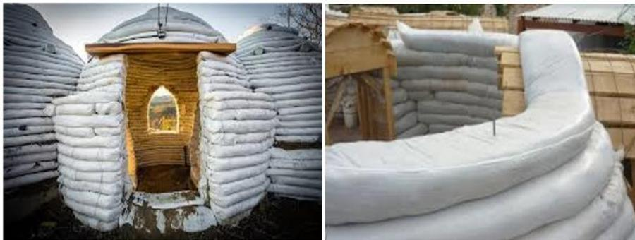
Figura 5. Casa construida con tierra ensacada.
