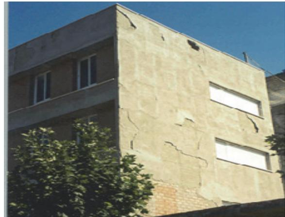
*Figura 1. Desprendimiento de mortero de revestimiento por inadecuado curado.*
