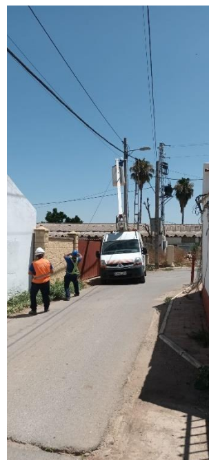
Fotografías 11 y 12: Trabajos de tendido de cable aéreo por postes empleando un camión-cesta en La Jarilla (La Rinconada). Fuente: fotos del autor.
