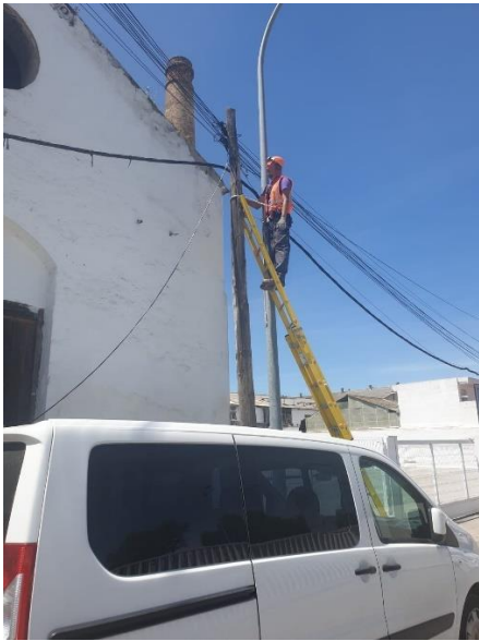
Fotografía 15: Operario desarrollando trabajos de tendido de cable aéreo por postes empleando el cinturón de posicionamiento, que previene las caídas de alturas, pero no las evita en San Jerónimo. Fuente: foto del autor.
