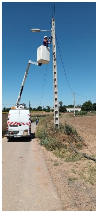
Fotografías 11 y 12: Trabajos de tendido de cable aéreo por postes empleando un camión-cesta en La Jarilla (La Rinconada). Fuente: fotos del autor.
