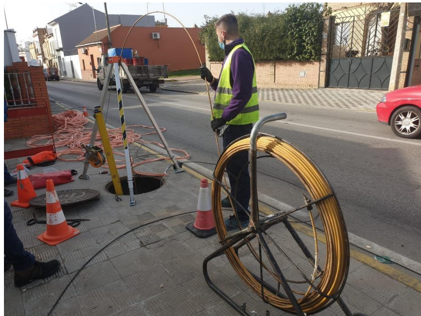
Fotografía 36: operario desenrollando la guía pasacables y pasándosela a su compañero dentro de la cámara de registro de telecomunicaciones para que la extienda a través de los conductos hacia la siguiente cámara en Benacazón. Fuente: foto del autor.
