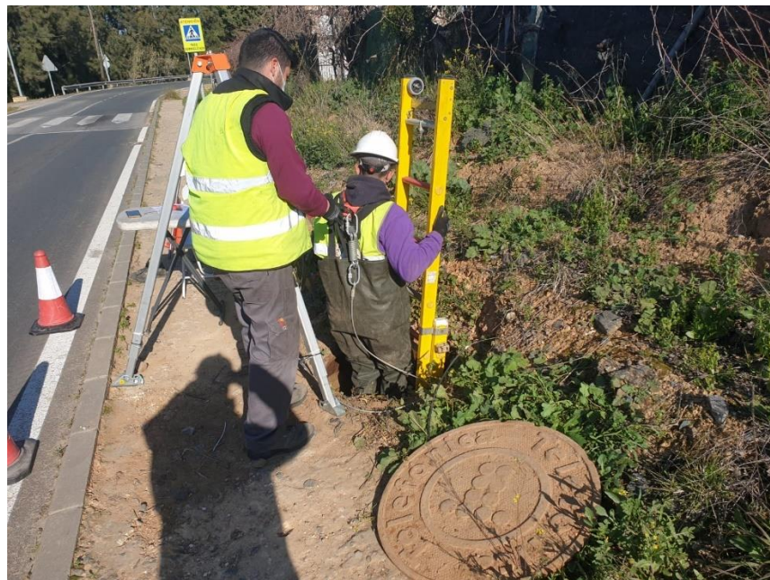
Fotografía 63: Operario bajando a una cámara de registro de telecomunicaciones en Sanlúcar la Mayor que se encuentra inundada equipado con vadeador de seguridad, guantes de protección mecánica, casco de seguridad y arnés de seguridad atado por su punto dorsal al trípode de rescate. Fuente: foto del autor.
