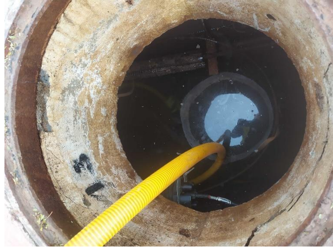
Fotografía 19: Ejemplo de cámara llena de lodo en Tomares en la que es necesario contratar a una empresa especializada en la extracción de aguas residuales y su transporte a una planta de tratamiento. Fuente: foto del autor.
