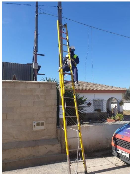
Fotografía 17: Trabajador suspendido de la línea de vida fijada a la escalera, teniendo ésta correctamente estabilizada en trabajos de tendido de cable aéreo por postes en La Hermandad (Dos Hermanas). Fuente: foto del autor.
