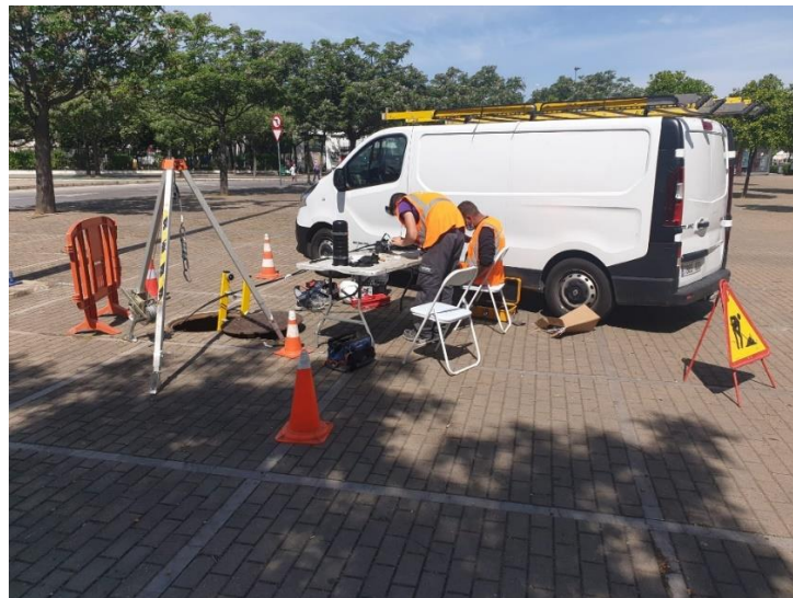
Fotografía 56: operarios realizando operaciones de conexionado de cables en la localidad de Sevilla, en la ronda del Tamarguillo desde fuera de la cámara de registro de telecomunicaciones en la que se aprecia cómo el cable sale de la cámara y llega hasta el empalme que está manipulando uno de los operarios mientras éstos están acomodados mediante mesa y sillas plegables. Fuente: foto del autor.
