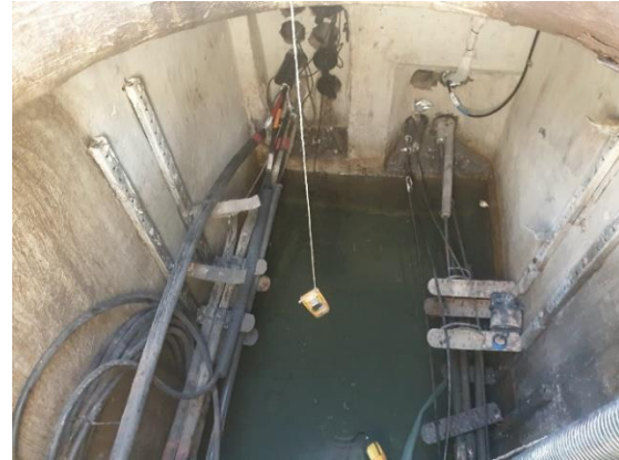
Fotografías 55 y 59: Medidor de gases introducido en una cámara de registro de telecomunicaciones mediante cuerda para realizar mediciones a distintas alturas previas a la entrada del trabajador en la cámara. Fuente: fotos del autor.
