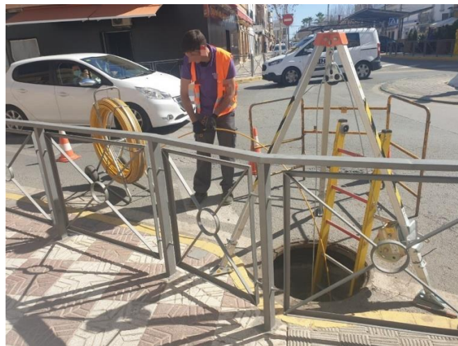
Fotografía 49: Operario desenrollando el cable guía desde el exterior de una cámara para que su compañero dentro de ella lo pase hasta la siguiente cámara. La cámara se encuentra en una rotonda de Brenes con un tránsito de vehículos considerable, poniendo a estos operarios en riesgo de atropello. Fuente: foto del autor.
