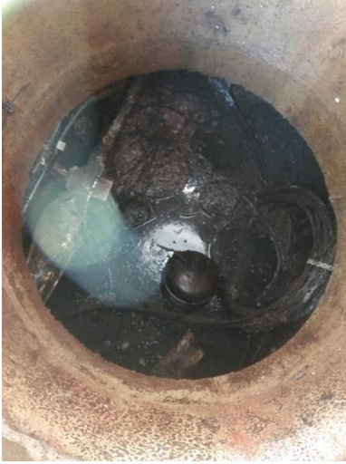
Fotografía 19: Ejemplo de cámara llena de lodo en Tomares en la que es necesario contratar a una empresa especializada en la extracción de aguas residuales y su transporte a una planta de tratamiento. Fuente: foto del autor.
