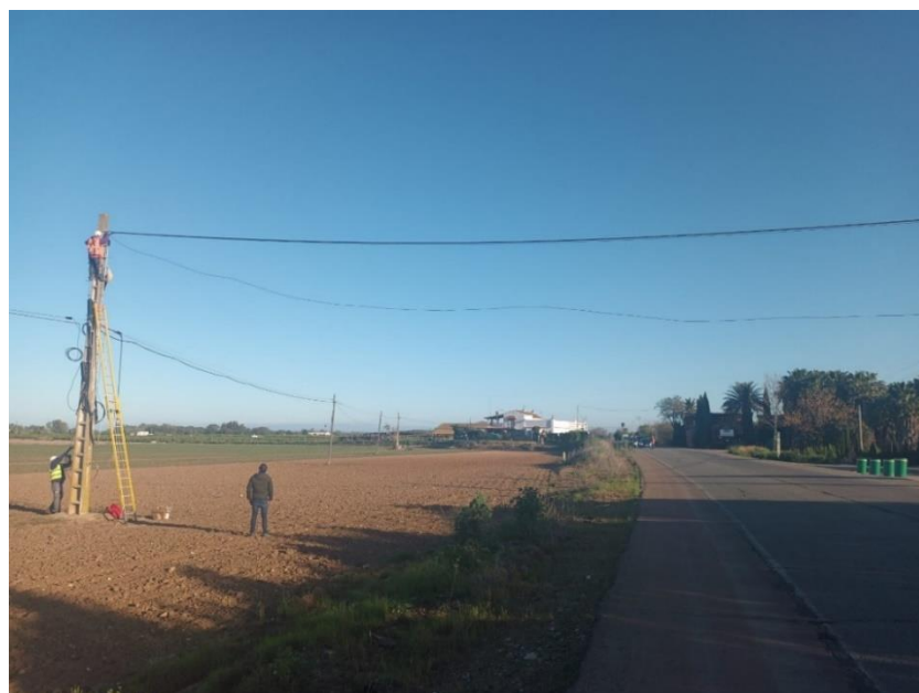
Fotografía 14.: Mismo operario situado a cota superior a la de la escalera realizando el paso aéreo por encima de la carretera con el tráfico cortado. Fuente: foto del autor.
