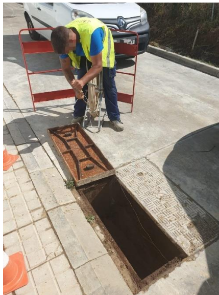
Fotografías 23 y 24: Operario recogiendo la guía de acero atada a la cuerda que queda tendida a través del conducto de una arqueta en Ayamonte. Fuente: fotos del autor.
