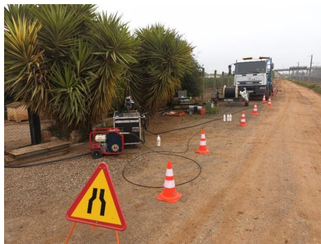
Fotografía 27: despliegue de cable de fibra óptica mediante la técnica de soplado con el compresor subido en el camión junto a Camino de la Reina (Sevilla). Fuente: foto del autor.
