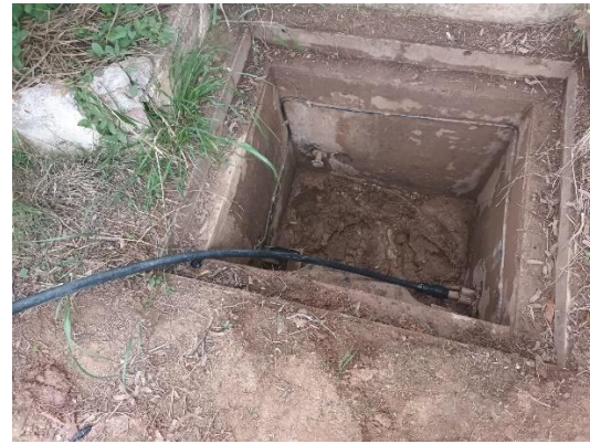
Fotografía 28, 29 y 30: sistema de conductos por donde llega el aire a presión desde el compresor y acaba en el conducto de la arqueta pasando antes por una maquinaria que fija debidamente el cable para que no sufra torsiones.
