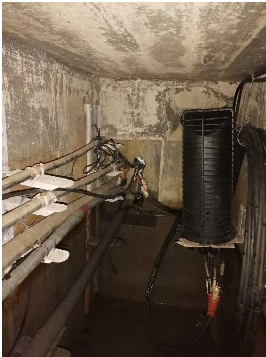
Fotografías 31 y 32: cajas de empalmes en cámaras de registro. Nótese que van acompañadas de una balona de cable, entre otras razones, como medida preventiva organizativa. Fuente: fotos del autor.
