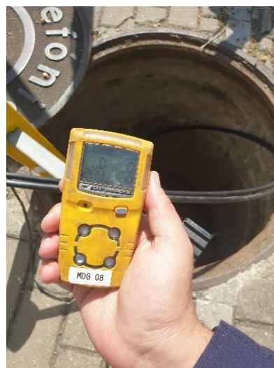
Fotografía 60: Medición correcta en la que se pueden leer los siguientes datos: sulfuro de hidrógeno ( H_2S ) 0 ppm; monóxido de carbono (CO) 0 ppm; oxígeno ( O_2 ) 20,9 %; y límite inferior de inflamabilidad (lower explosive limit, LEL) 0 ppm. Fuente: foto del autor.
