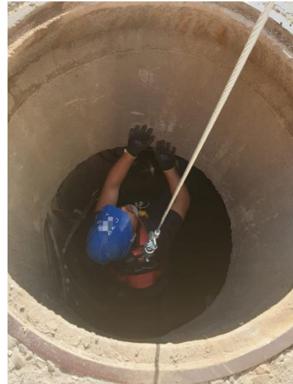
Fotografías 54 y 55: Trabajador haciendo un mal uso del trípode de rescate empleándolo como medio de acceso y salida a una cámara de registro de telecomunicaciones en La Puebla del Río. Fuente: fotos del autor.
