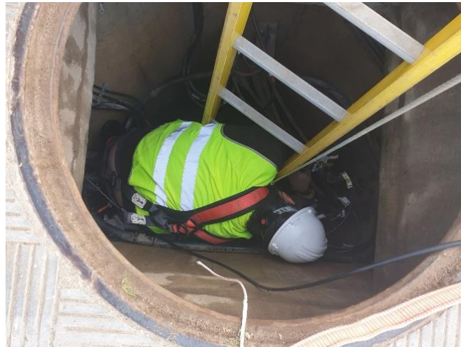
Fotografía 41: Operario realizando labores de tendido de cableado de telecomunicaciones en el interior de una cámara de registro en Benacazón viéndose obligado a adoptar una postura forzada. Fuente: foto del autor.
