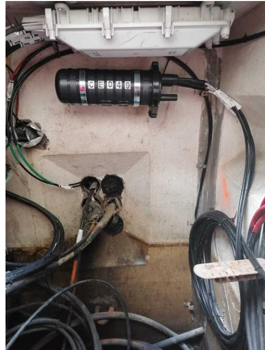
Fotografías 31 y 32: cajas de empalmes en cámaras de registro. Nótese que van acompañadas de una balona de cable, entre otras razones, como medida preventiva organizativa. Fuente: fotos del autor.
