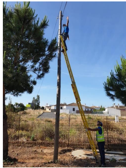
Fotografía 15: Operario desarrollando trabajos de tendido de cable aéreo por postes empleando el cinturón de posicionamiento, que previene las caídas de alturas, pero no las evita en San Jerónimo. Fuente: foto del autor.
