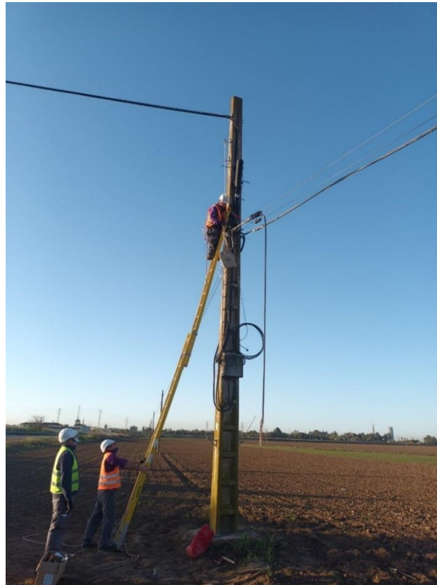
Fotografía 13: Operario instalando pernos de anclaje en un poste de hormigón para subirse él mismo al poste a una altura por encima de la escalera en la carretera de La Algaba A-8006. Fuente: foto del autor.
