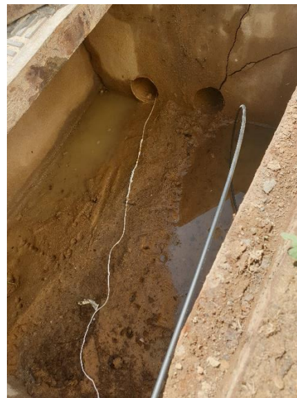
Fotografías 23 y 24: Operario recogiendo la guía de acero atada a la cuerda que queda tendida a través del conducto de una arqueta en Ayamonte. Fuente: fotos del autor.
