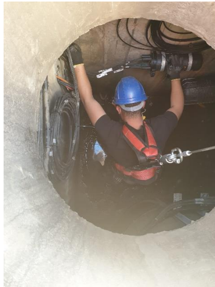
Fotografías 54 y 55: Trabajador haciendo un mal uso del trípode de rescate empleándolo como medio de acceso y salida a una cámara de registro de telecomunicaciones en La Puebla del Río. Fuente: fotos del autor.
