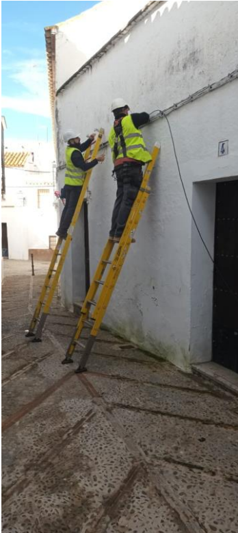
Fotografía 06: Operarios realizando labores de tendido de fibra óptica por fachada en el municipio de Carmona. Fuente: foto del autor.
