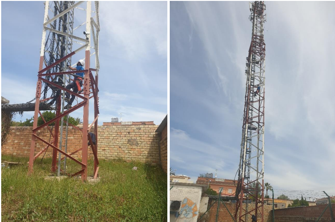
Fotografías 03 y 04: Secuencia en la que un operario sube a una torre de telecomunicaciones en Castilleja de la Cuesta mediante un sistema de doble anclaje para realizar trabajos de radioenlace dentro del volumen de protección radioeléctrica con los emisores previamente desconectados. Fuente: fotos del autor.
