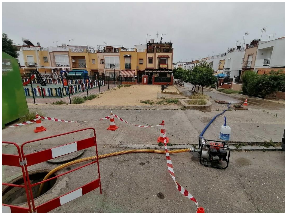
Fotografía 57: Desaguado de cámara mediante motobomba colocada lo más alejada posible de la cámara y en posición tal que la salida de gases vaya en sentido opuesto a la cámara. Fuente: fotografía cedida por compañero de Beteling Consultoría e Ingeniería S.L.
