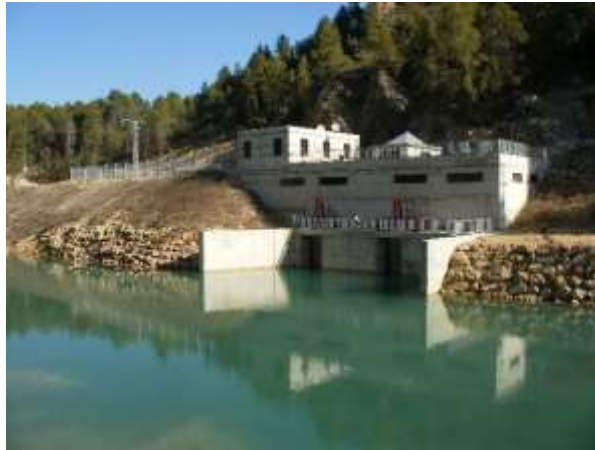
Figura 38. Central minihidráulica ubicada en Fuensanta, Albacete de 9 MW de potencia
