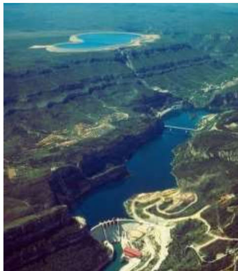
Figura 58. Central hidroeléctrica de bombeo La Muela II, Cortes de Pallàs, Valencia, con 880 GW de
