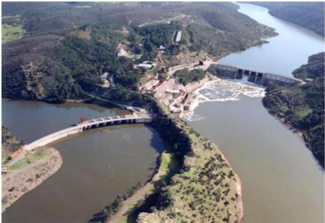
Figura 56. Central con bombeo mixto en Torrejón, en el cauce de los ríos Tajo y Tiétar. 140 MW de potencia
