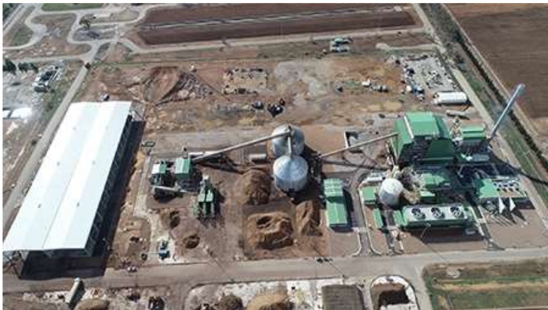
Figura 43. Planta de Biollano, Ciudad Real, con una potencia de 50 MW
