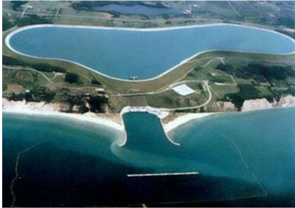
Figura 55. Central de bombeo puro en el lago Michigan. 1872 MW.
