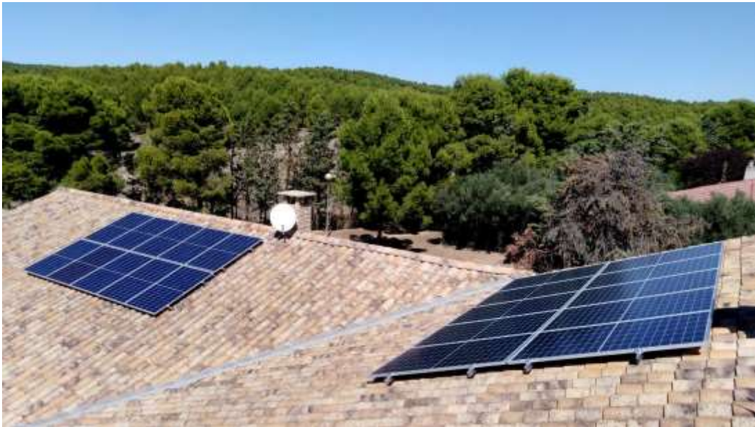
Figura 2. Instalación de paneles fotovoltaicos en la fachada de una vivienda.
