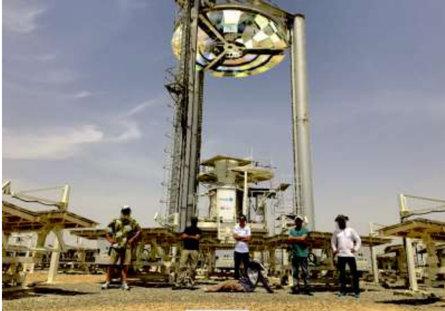
Figura 71. Receptor solar sobre sales
