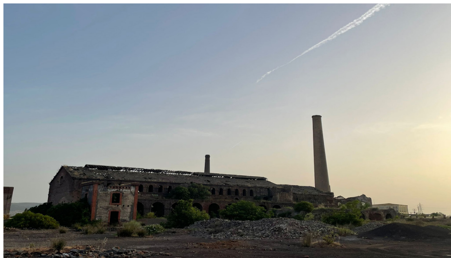
Visión actual de uno de los edificios del CERCO INDUSTRIAL en Peñarroya-Pueblonuevo, Córdoba.
