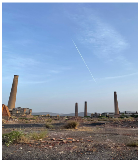
Conesrvación actual de algunas de las chimeneas del Cerco Industrial de Peñarroya-Pueblonuevo, Córdoba.
