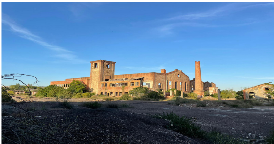
Restos del CERCO INDUSTRIAL en la actualidad en Peñarroya-Pueblonuevo, Córdoba.
