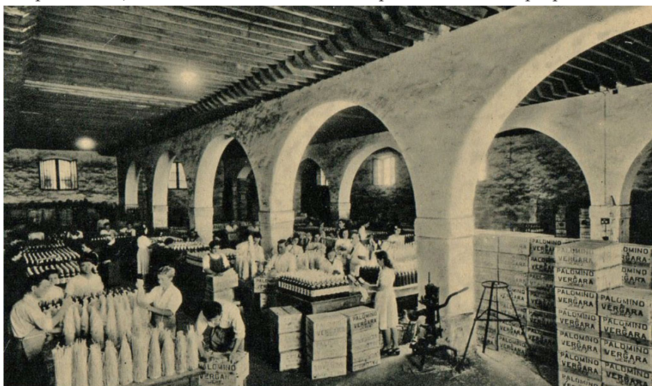
Interior de una BODEGA de Jerez de la Frontera , en una tarjeta postal de la década de 1920. Fuente: Junta de Andalucía
