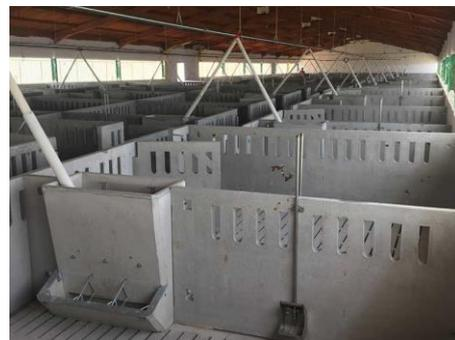
*Figura 12: Separadores Laterales de Hormigón Prefabricado.*
