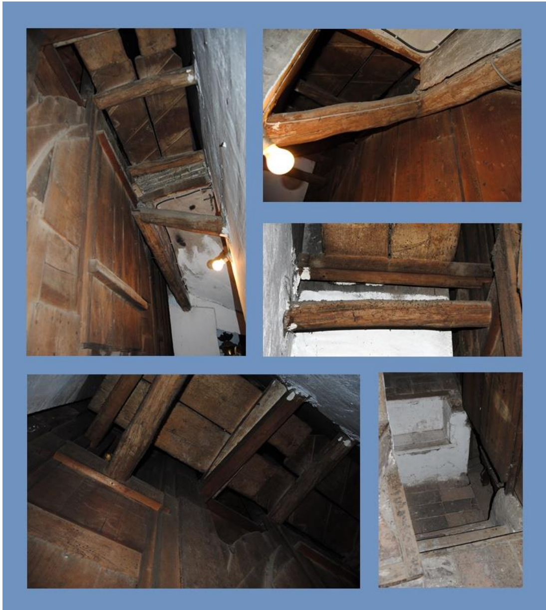
Fig. 10: Estructura del primer cuerpo, anclajes, vigas y escalones posteriores al camarín de San Nicolás (Fotos: Gonzalo Borrego)
