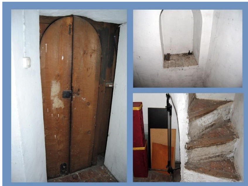
Fig. 7: izquierda : Vista interior de la puerta de acceso. Superior derecha : Hornacina con arco semicircular. Inferior derecha : Escaleras y objetos (Fotos: Gonzalo Borrego)
