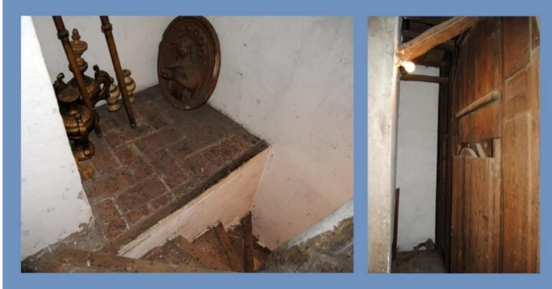
Fig. 8: izquierda : Detalle del espacio adicional . Derecha : Interior del primer cuerpo (Fotos: Gonzalo B.)
