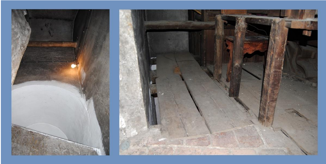
Fig. 11: izquierda : muros y anclaje. Derecha : Detalle del suelo del segundo piso (Fotos: Gonzalo B.)
