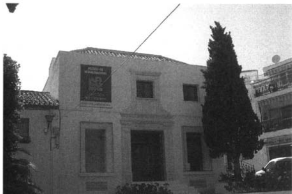
Museo precolombino de Benalmádena. Arquitecto D. Raul Gantes Rodríguez. Estado actual. Reforma 2003-2005
