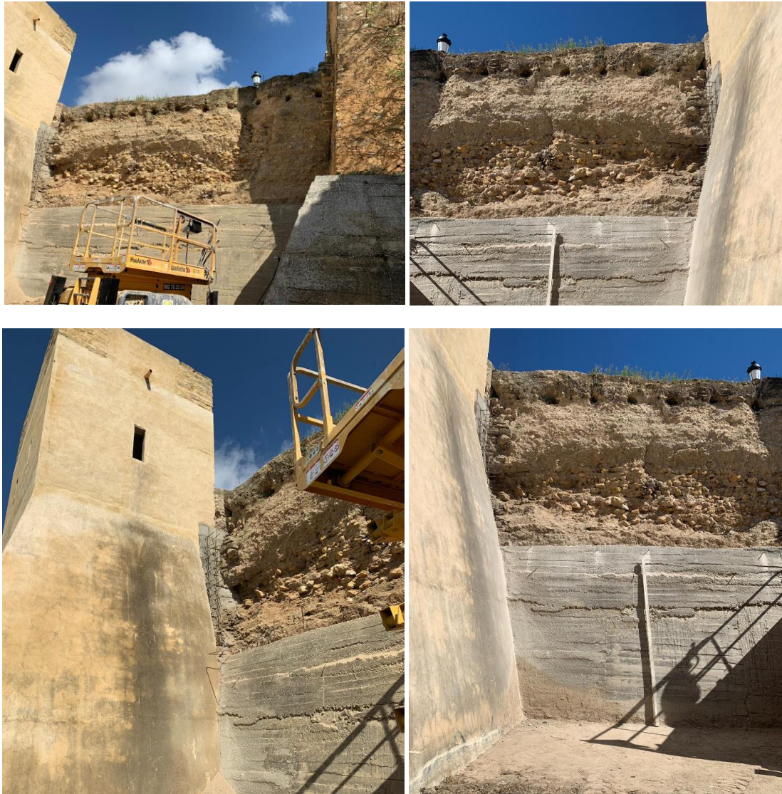
Ilustración 41. Zona de actuación, rehabilitación del castillo de Utrera, Sevilla.
