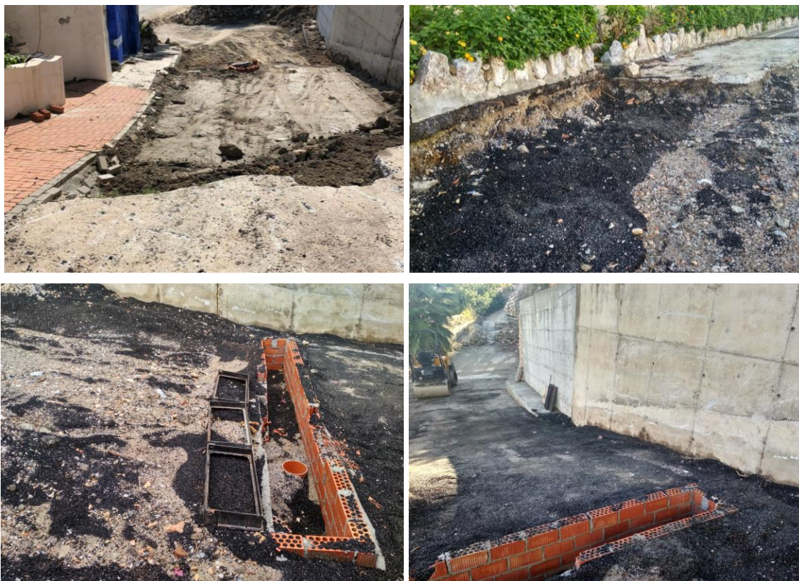
Ilustración 40. Puesta en obra del Granulado de NFU's en Urbanización Cármenes del Mar como sistema de aligeramiento de peso en zonas con asentamientos.
