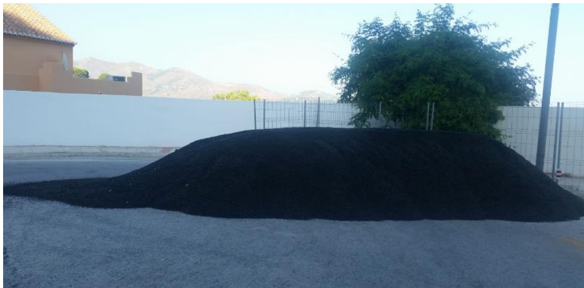
Ilustración 39. Acopio del granulado de NFU's en urbanización Cármenes del Mar como sistema de aligeramiento de peso en zonas con asentamientos.
