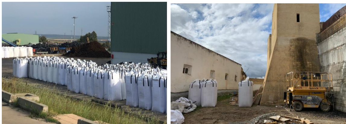
Ilustración 43. Acopio de Granulado de NFU's. (Izquierda planta de tratamiento, derecha obras de actuación Muro castillo de Utrera).
