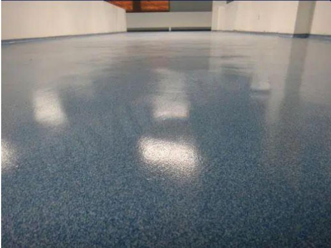
**Figura 30.** Suelo multicapa Epoxi de Cuarzo del fabricante Pavidepor. [34]
