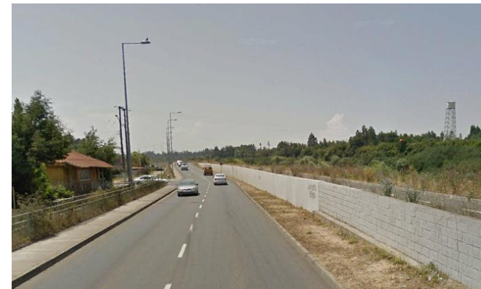
Imagen 48 presencia de carril bici, espalda al río
