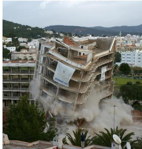
**Imagen 7:** Voladura en demolición. Fuente: dmol.es.
