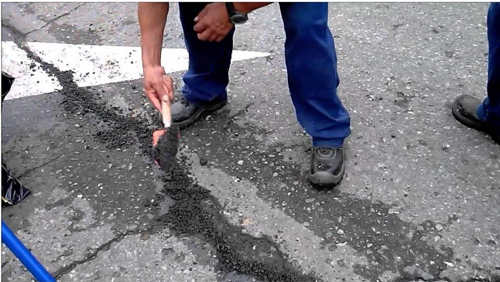
**Imagen 10:** Reparación de grietas en el asfalto **Fuente:** Canal de YouTube de ROKASFALTO.
