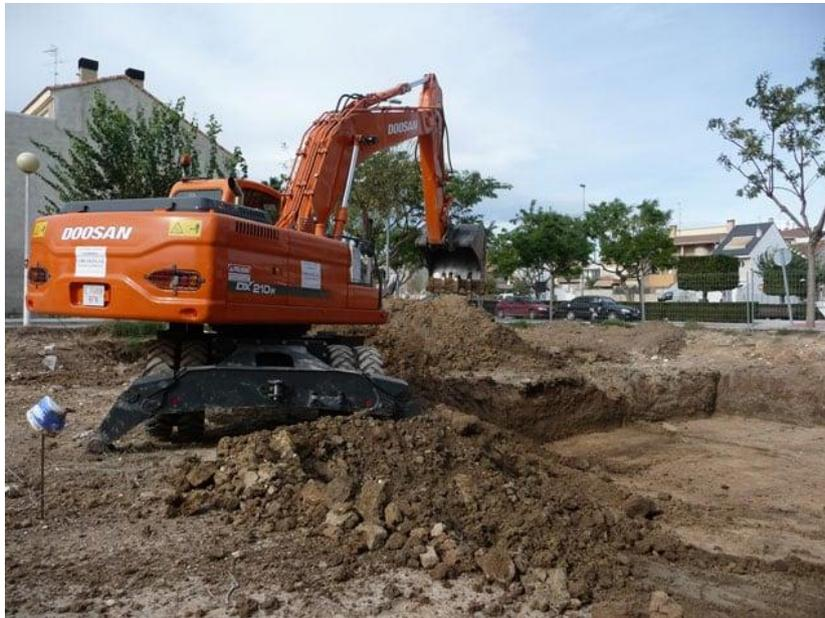
Imagen 2: Ejecución de un desmote. Fuente: arpape.com.
