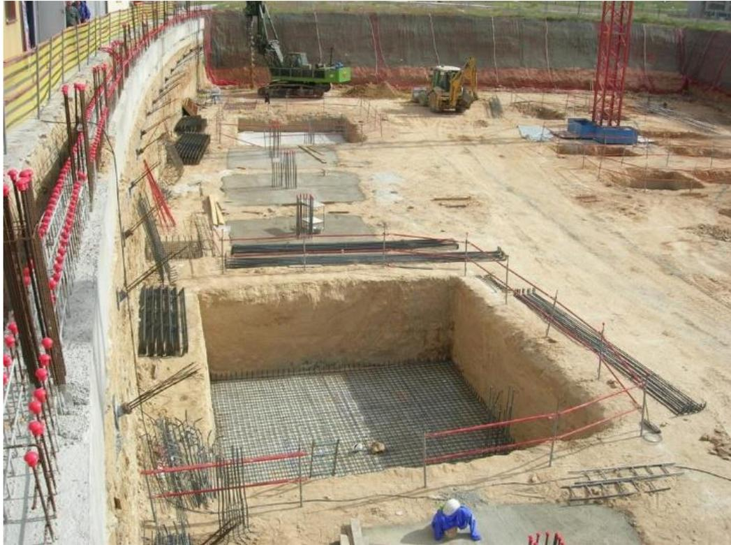
Imagen 4: Pozo ejecutado y listo para realizar una zapata. Fuente: arpape.com.
