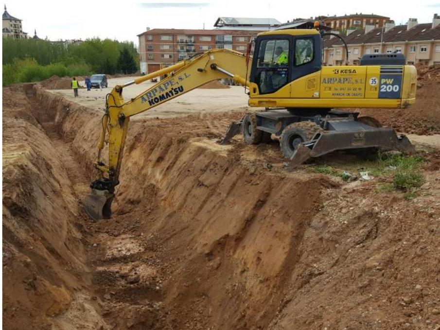
Imagen 3: Ejecución de una zanja con medios mecánicos. Fuente: arpape.com.
