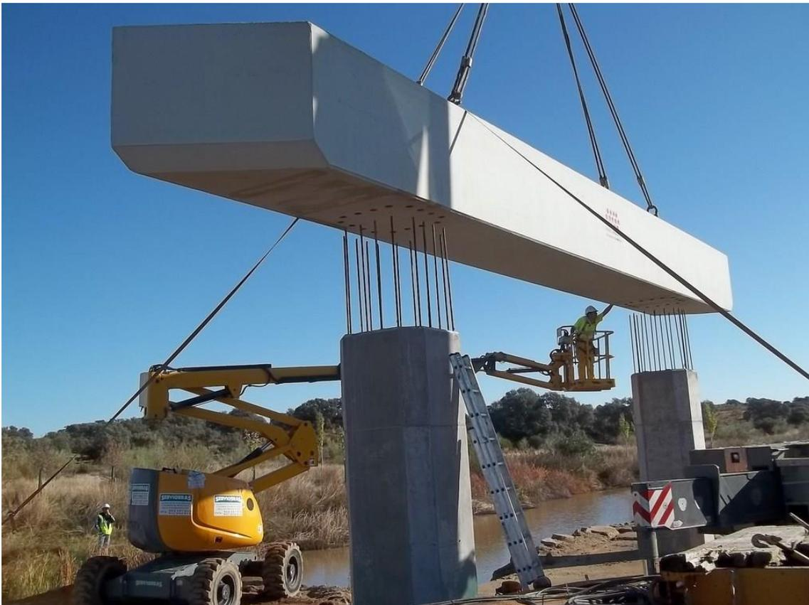
Imagen 11: Montaje de estructura prefabricada de hormigón armado. Fuente: revealedized.com.
