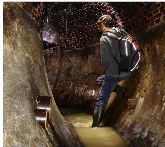
Imagen 17: Alcantarillado transitable en forma de ovoide. Fuente: imesapi.es.
