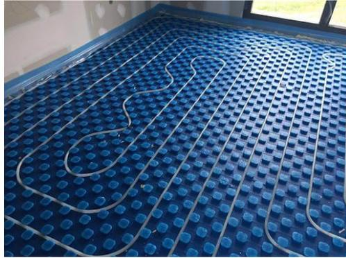
Figura 4-12. Tuberías de suelo radiante sobre plancha aislante
