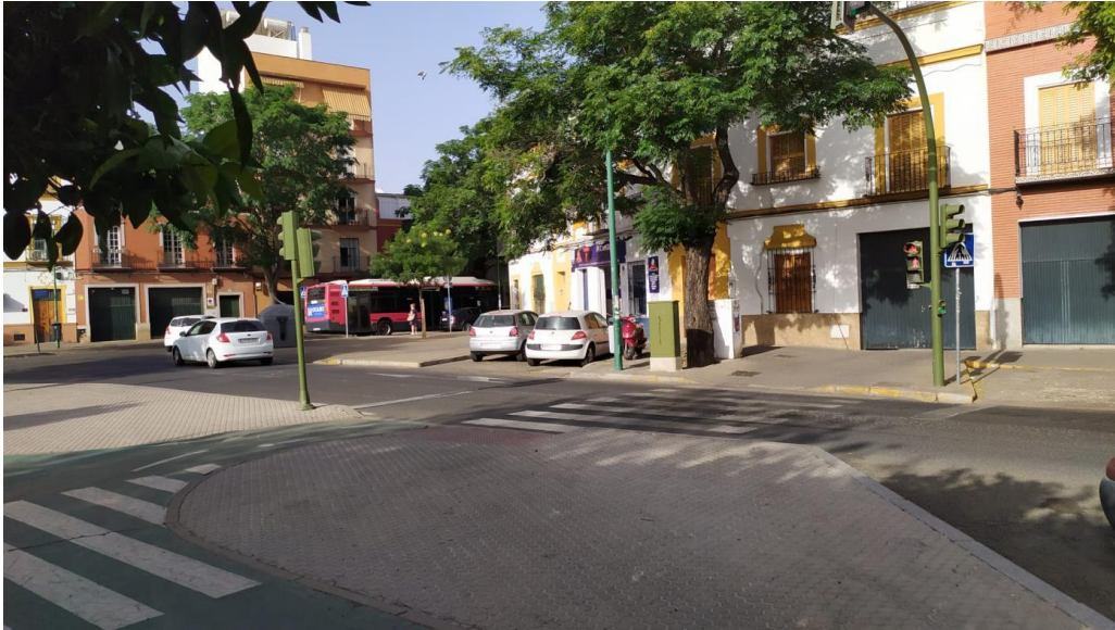
Figura 19. Marquesina desde calle Manuel Villalobos dirección Fray Isidoro de Sevilla
