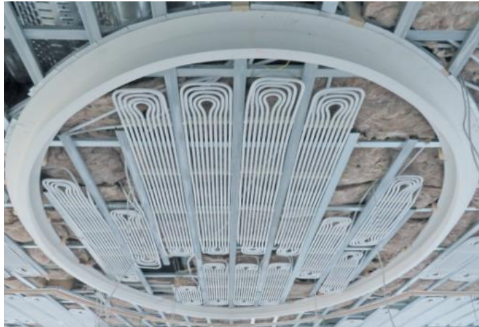
Figura 10. Sistema convectivo-radiante (Thermatop)
