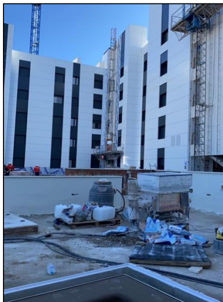
Imagen 1. Ubicación del parapeto
