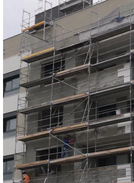
Imagen 2. Ejecución del enfoscado
