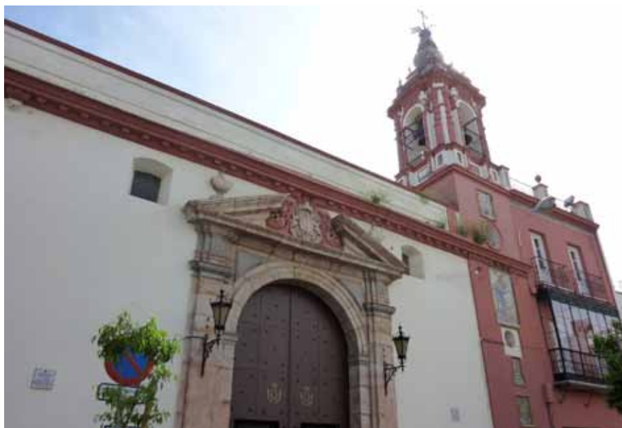
Figura 1-b. Fachada de la iglesia de la O.
