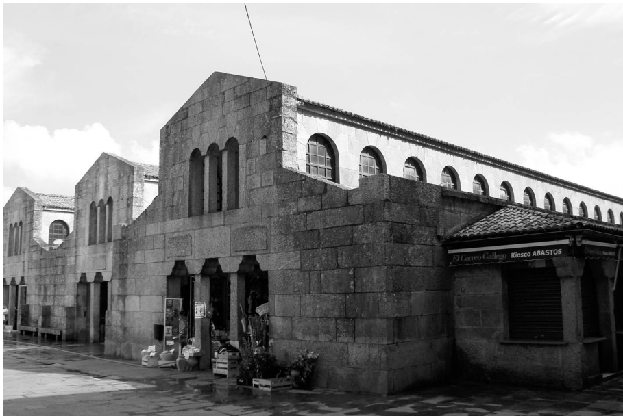
Figura 1. Plaza de Abastos de Santiago de Compostela.
