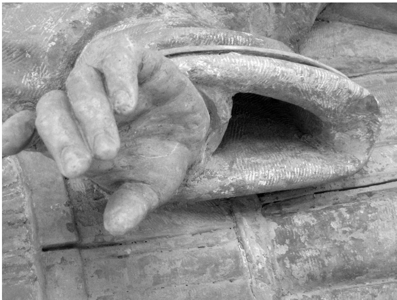
Figura 3. Sistema de unión de la mano a la bocamanga de la túnica en una figura de la puerta de la Entrada en Jerusalén. Catedral de Sevilla.
