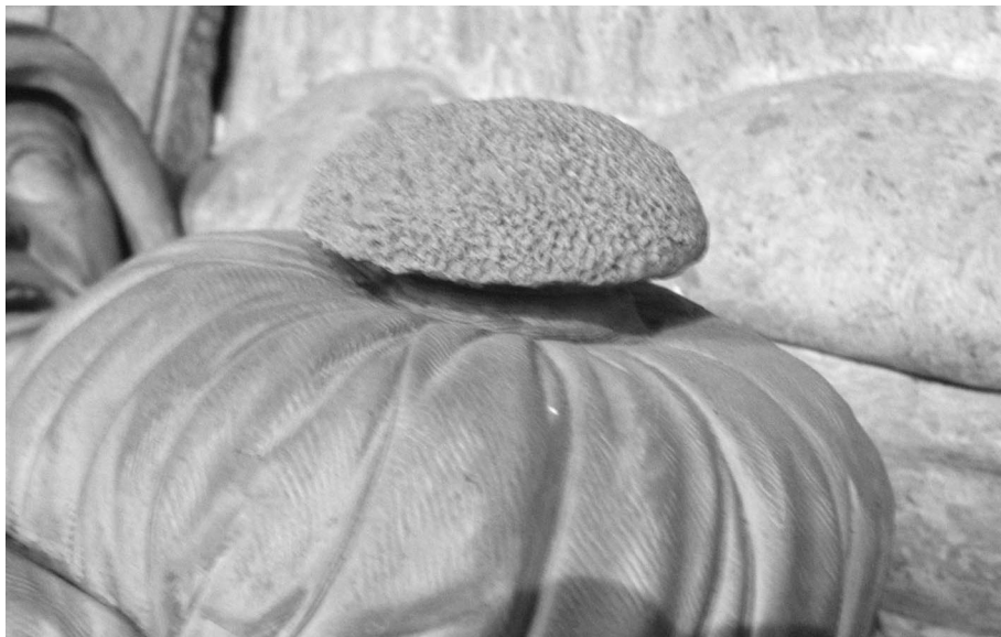
Figura 6. Tocado de una figura del relieve de la expulsión de los mercaderes del Templo: la borla cierra el orificio efectuado para evitar la condensación de humedad durante el proceso de cocción. Puerta del Perdón. Catedral de Sevilla.
