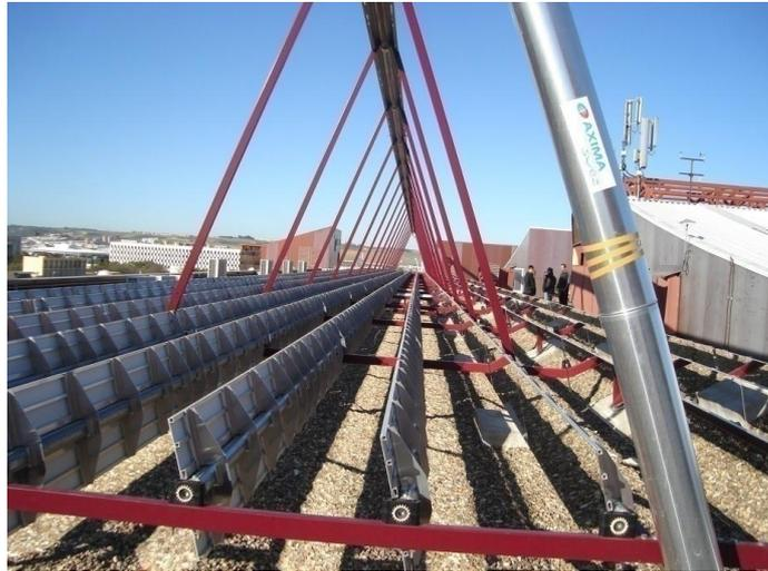
**Figura 3-6.** Estructura de acero del colector solar.
