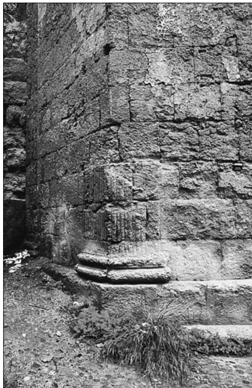
Foto 8. Pilastra de la torre sur y restos de revestimientos sobre el aparejo romano
