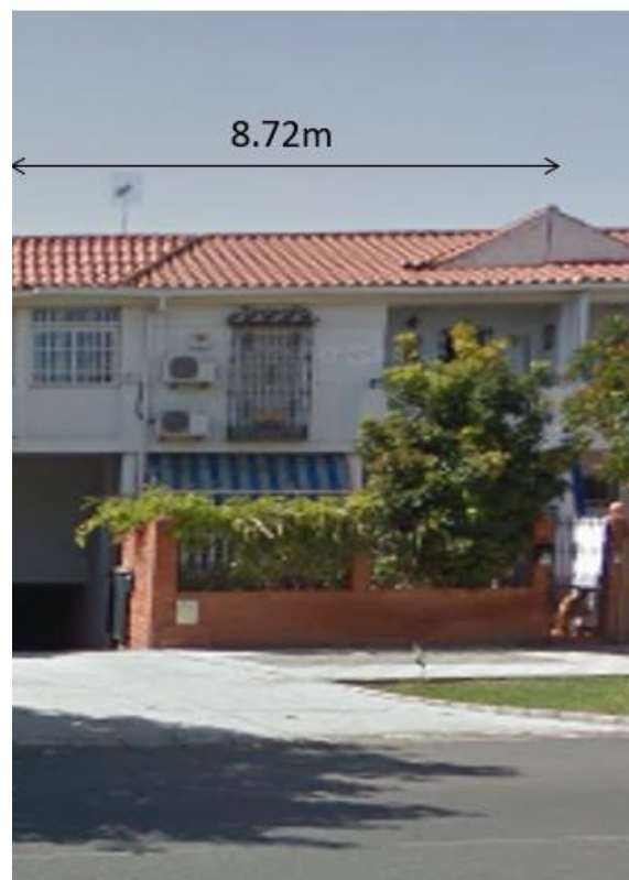
Figura 57. Imagen frontal de la vivienda donde ubicar los paneles solares en la cubierta.
