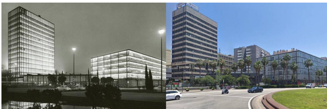
IMG. 11. Depósito de automóviles de la Seat, antes y después de la intervención.
