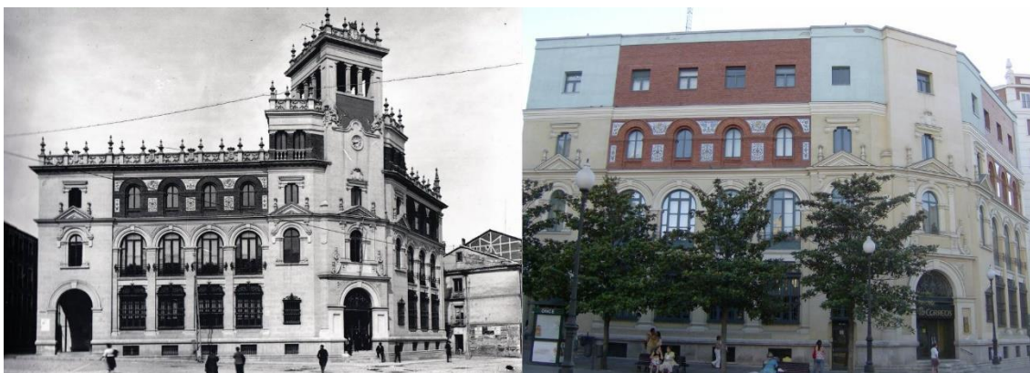
IMG. 13. Palacio de correos y telégrafos antes y después de la intervención.
