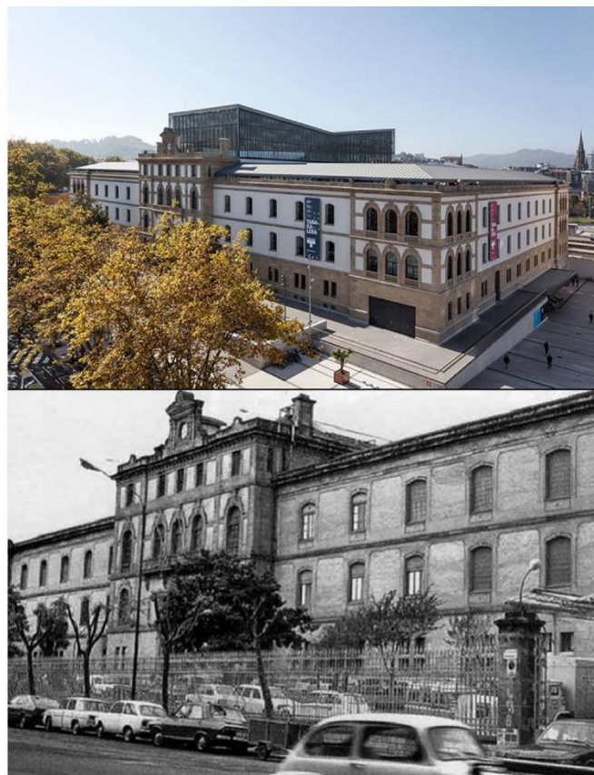
IMG. 15. La Fábrica de Tabacos de San Sebastián y telégrafos antes y después de la intervención.
