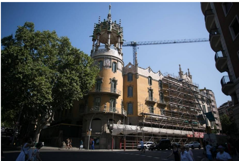
IMG. 14. La Rotonda durante la intervención.
