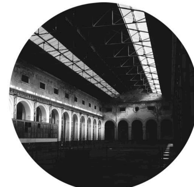
- Nave neoclásica interior -
