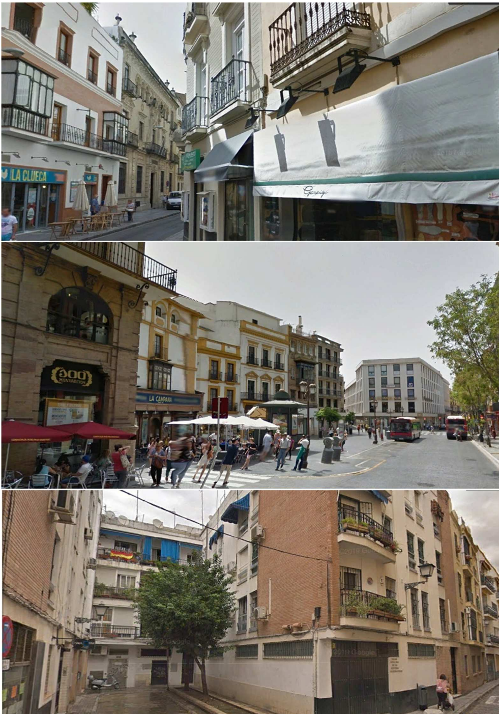
Imagen 5.4.8.1.6 Tipologías de Vivienda, Vivienda Unifamiliar y Multifamiliar en Barrio Encarnación, Distrito Casco Antiguo, Sevilla Año 2019.
