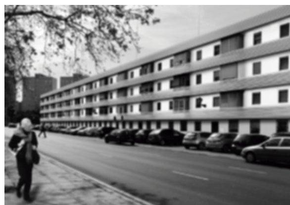
b) Estado rehabilitado
