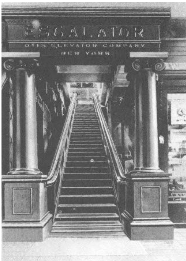
Figura 2. Escalera mecánica Otis
