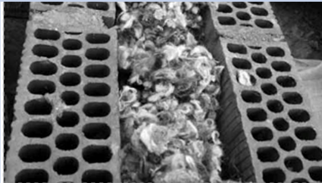
[Figura 13: Fibra de lana puesta en obra como material aislante. Fuente: Wadel, G. 2009. Aislamientos térmicos renovables y reciclados de lana de oveja y algodón: un aporte a la construcción sostenible. Revista de Arquitectura 15(20): 27.]
