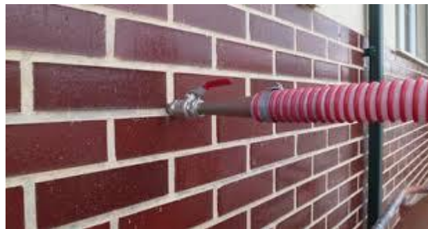
[Figura 29: Insuflado de aislamiento térmico en cámara de aire. Fuente: certificadosenergéticos.com]
