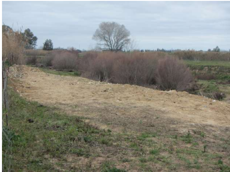
Foto 63. Refuerzo de la orilla de la margen izquierda con escombros del tramo bajo del arroyo de La Cárcava donde no se ha reforzado con escollera para evitar la progresión de la erosión (Estación de muestreo nº 13).
