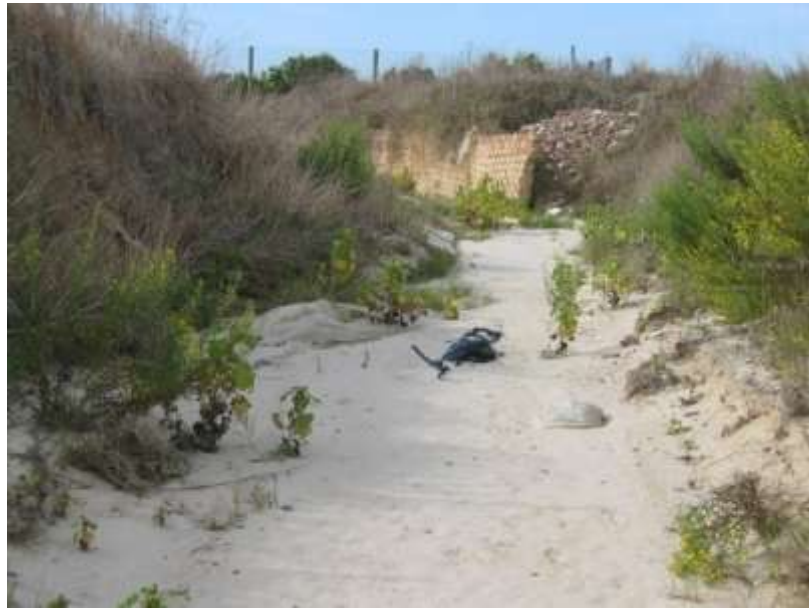
Foto 8. Construcción de un muro de ladrillos, con refuerzo de escombros, ubicado en el lado externo de la curvatura de un tributario del A. Cárcava para intentar evitar que el arroyo ocupe parte de una parcela agrícola. (Estación de muestreo nº 52).
