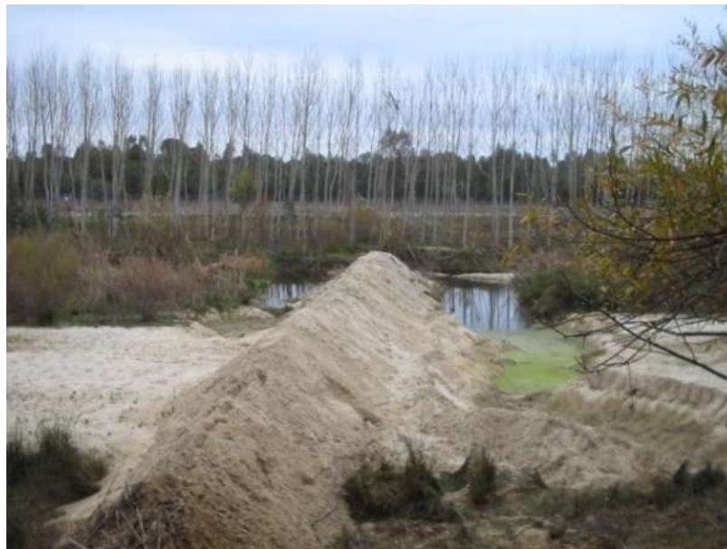
Foto 71. Construcción de represas artificiales transversales al canal que interrumpe el flujo en las inmediaciones del vado del Chivo (Estación de muestreo nº 36).
