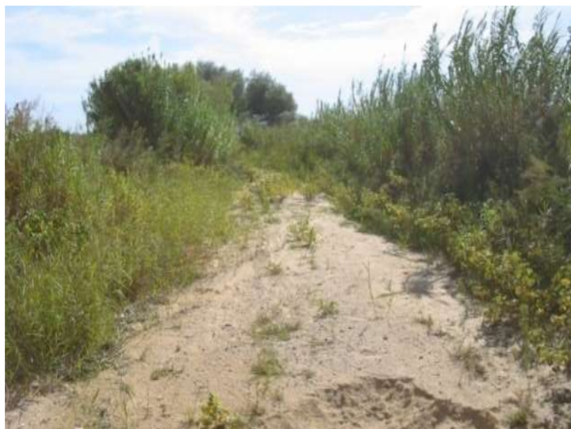
Foto 27. Cauce totalmente colmatado en el que apenas se percibe la sección del canal en el tramo del arroyo de La Cárcava localizado al SW del núcleo urbano de Bollullos Par del Condado (Estación de muestreo nº 54).
