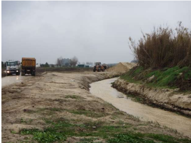
Foto 47. Tareas de desobstrucción mecánica del arroyo Colmenar en el invierno de 2013 debido a la colmatación del lecho. Obsérvese al fondo de la imagen la altura del material extraído apilado (Estaciones de muestreo nº 65-61).
