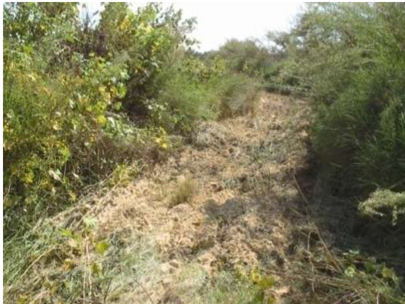
Foto 16. Limpieza y arrastre de materiales del fondo del canal con maquinaria pesada a la salida del arroyo Calancha por la Autovía A-49 (Estación de muestreo nº 56).
