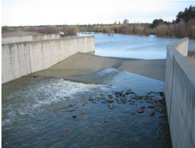
Foto 82. Canalización artificial ubicada en el puente del camino de El Rocío a Hinojos (Estación de muestreo nº 31).
