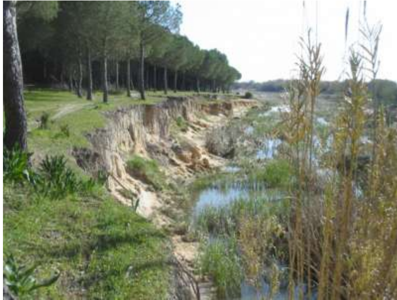
Foto 79. Progresión de la erosión de las orillas con dispositivo verticalizado en la margen izquierda del tramo de La Palmosa (Estación de muestreo nº 33).
