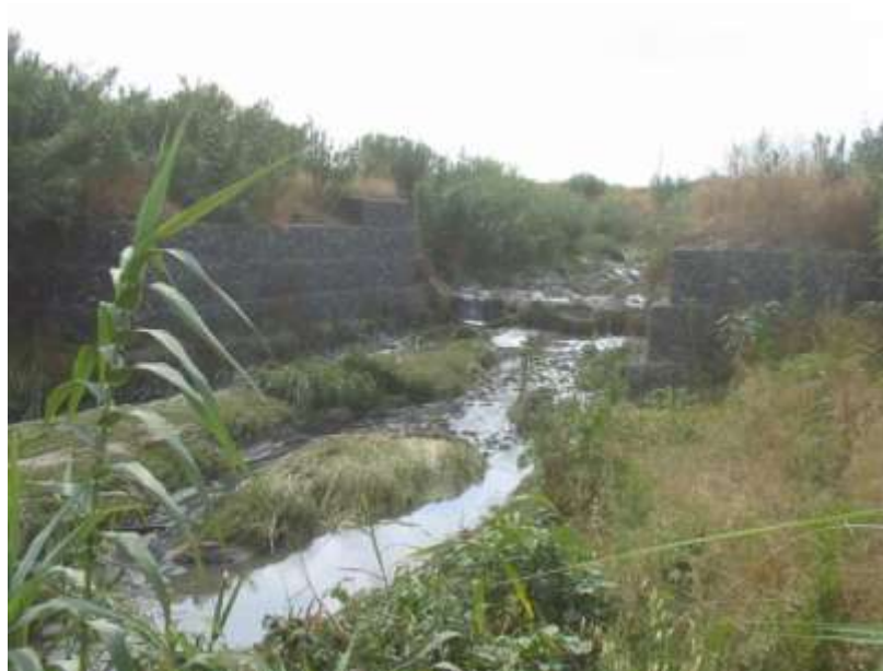
Foto 44. Tramo rectificado y refuerzo de las orillas mediante sistema de gaviones de 4 alturas y umbrales transversales de fondo aguas abajo de la confluencia del A. de La Cárcava y la Autovía A-483 (Estación de muestreo nº 11).
