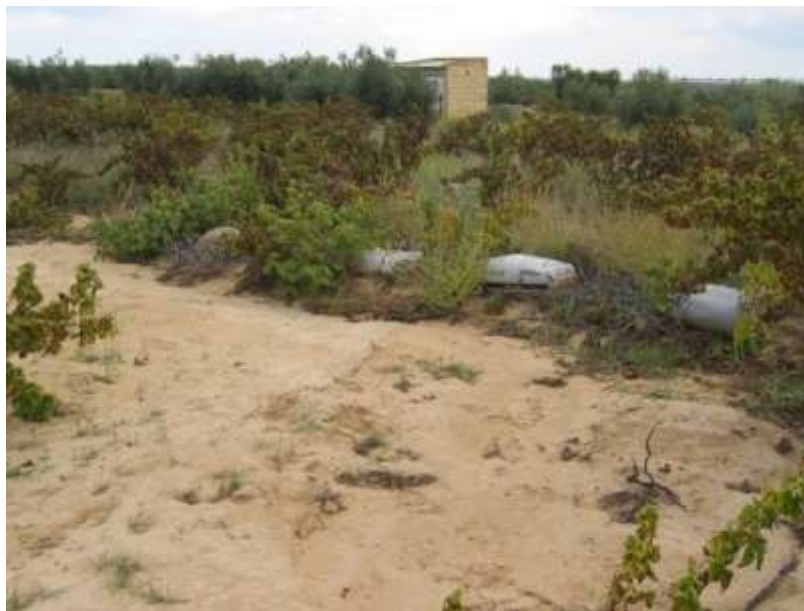
Foto 7. Peraltado de orillas de un tributario del arroyo Cárcava en su margen derecha constituido por sacos terreros al desaparecer la sección del cauce por colmatación (Estación de muestreo nº 68).
