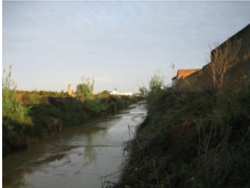
Foto 37. Canal artificial del arroyo Calancha con losa de hormigón en el núcleo urbano de Rociana del Condado (Estación de muestro nº 60).
