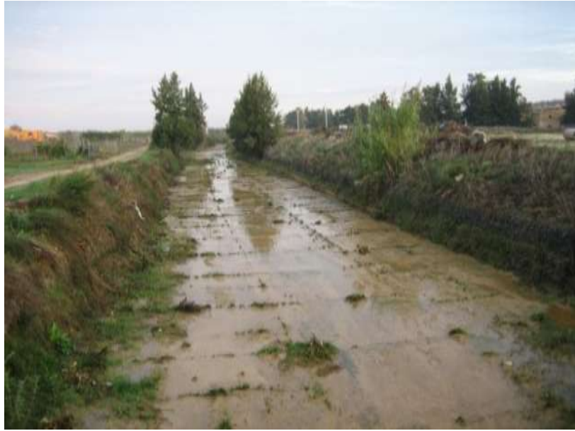
Foto 35. Canalización artificial del arroyo Calancha compuesta por losa de hormigón y orillas de gaviones de 2 alturas aguas arriba del núcleo urbano de Rociana del Condado (Estación de muestreo nº 60).
