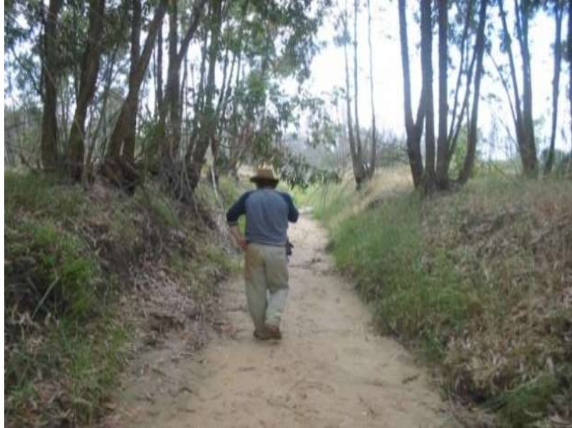
Foto 25. Canal rectificado y con el fondo relleno de material sedimentario en el tramo alto del arroyo Colmenar (Estación de muestreo nº 63).
