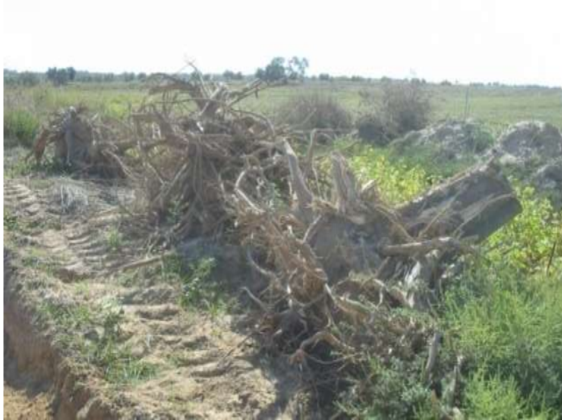
Foto 15 Refuerzo del peralte de las orillas mediante el uso de tocones de eucaliptos en la cabecera del arroyo Calancha (Estación de muestreo nº 56).
