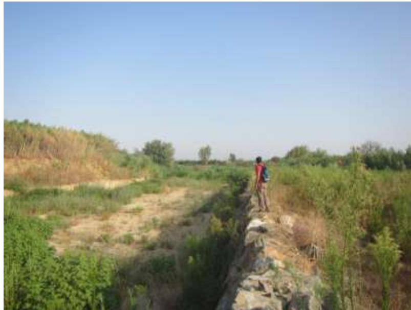
Foto 61. Muro de escollera con dispositivo lineal en el canal del tramo rectificado del arroyo de La Cárcava (Estación de muestreo nº 13).
