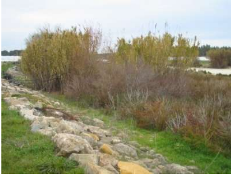
Foto 78. Refuerzo de las orillas con escolleras en el tramo aledaño a La Palmosa (Estación de muestreo nº 37).
