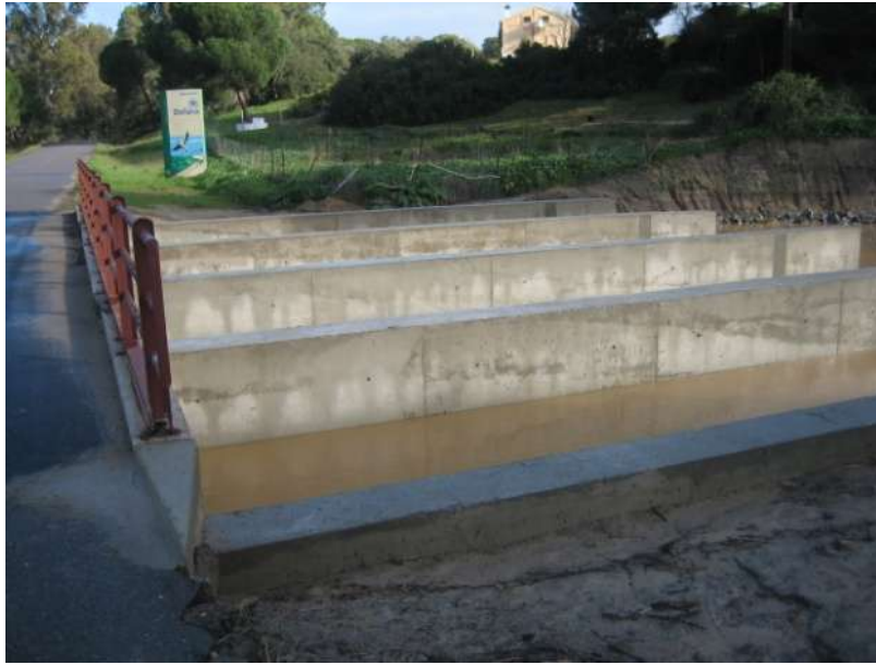
Foto 84. Paso de agua del puente ubicado paraje de la Casa de La Matanza que da salida al arroyo de La Parrilla en dirección hacia la marisma una vez desconectado del arroyo de El Partido como resultado de las actuaciones del Proyecto Doñana 2005 (Estación de muestreo nº 31).
