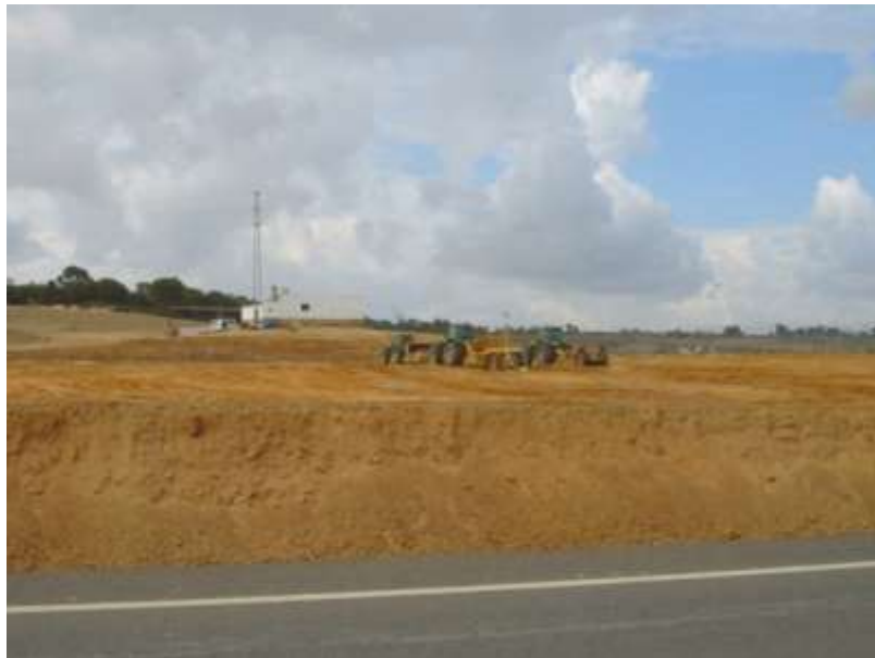
Foto 21. Preparación de parcelas con maquinaria pesada para la implantación de invernaderos junto a la carretera A-484, en la margen izquierda del arroyo Colmenar (Estación de muestreo nº 63).
