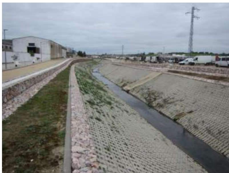
Foto 39. Tramo urbano del arroyo de la Cerrada a su paso por la localidad de Bollullos Par del Condado, con sellado de mampostería y en forma de V (Estación de muestreo nº 67).
