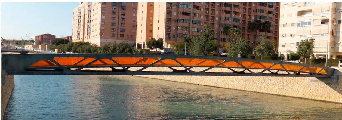
**Figura 7.** Pasarela de hormigón de ultra-altas prestaciones sobre el Barranco de las Ovejas (Alicante).
